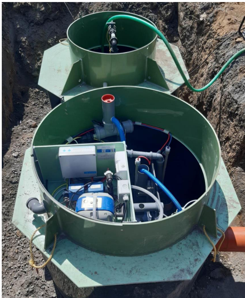
Obr. 9: Ukázka zabudované ČOV (vlastní foto, 14. 6. 2023)
