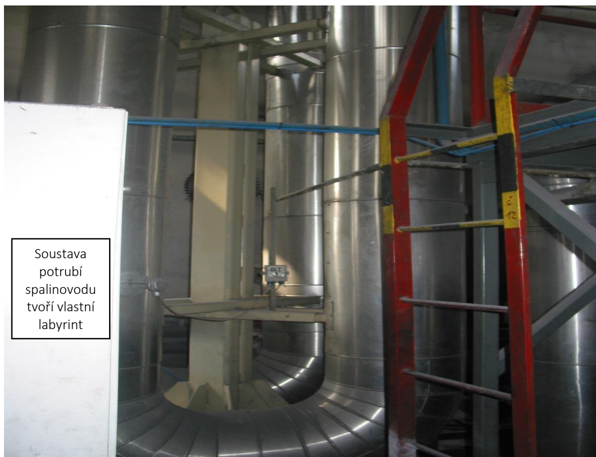
Obrázek 58: Detail spalínového labyrintu
