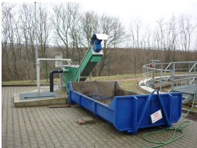
Obr. č. 4: Vertikální lapák písku se separátorem
