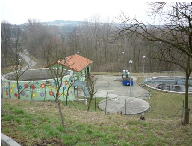
Obr. č. 1: Celkový pohled na ČOV
