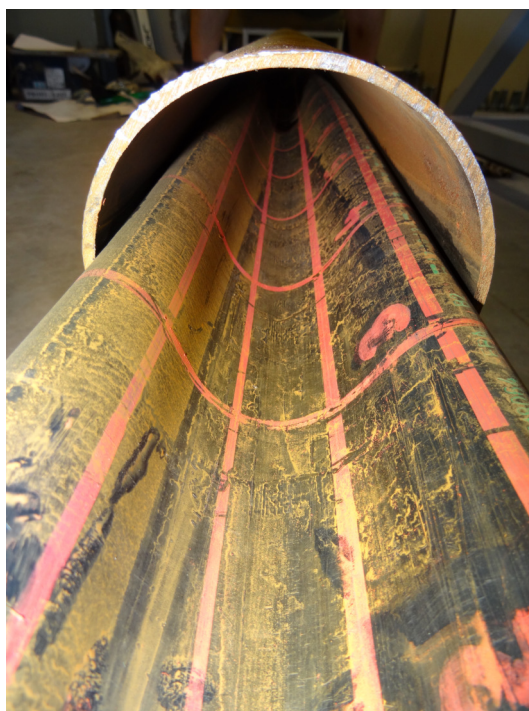
Obr. 14.81 Deformace termoplastového potrubí - pohled do ocelového potrubí (vzorek B-D110-SDR17-SV-1)
