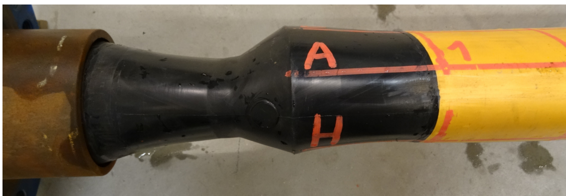
Obr. 14.57 Deformace potrubí - detail (vzorek A-D160-SDR11-BV-2)
