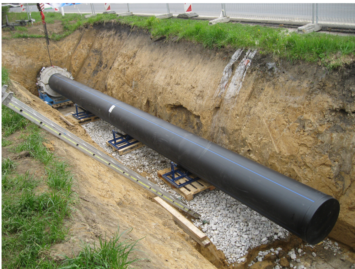
Obr. 2.4 Renovace potrubí technologií Relining v ulici Plzeňské v Ostravě
