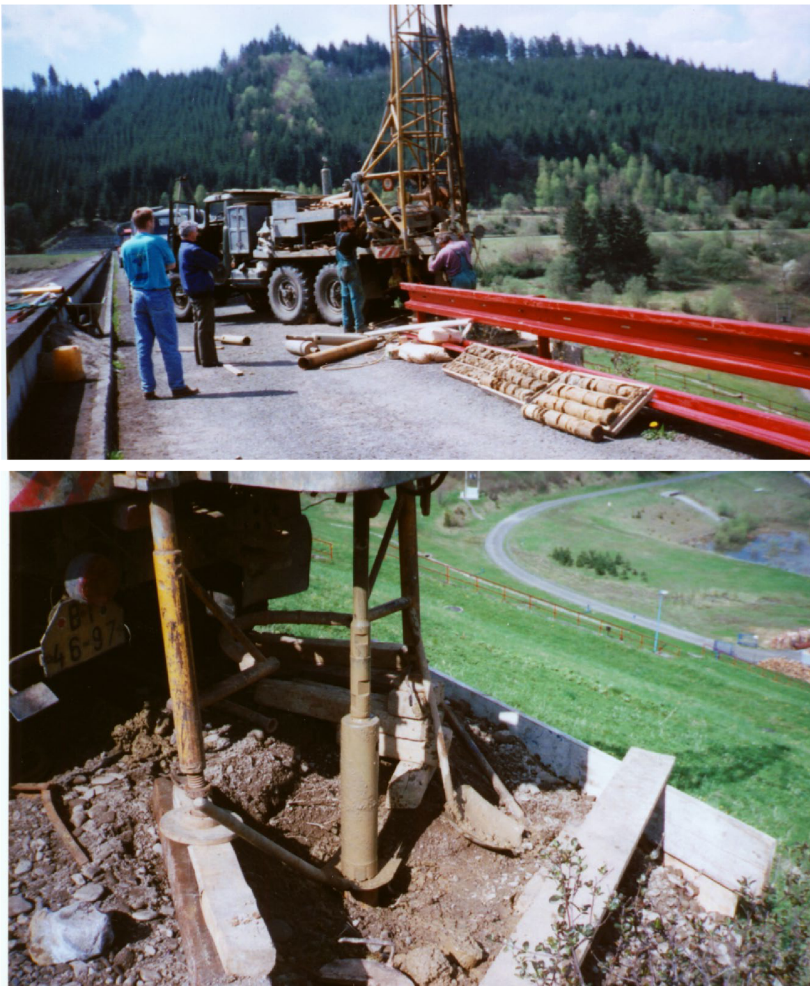
Obrázek 34 – Realizace IGP – vrt na VD Karolinka firmou GEOTest v roce 1999 [32]
