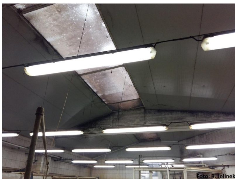
Obrázek 27: Pohled na světlík, veden přes celou dojírnu
