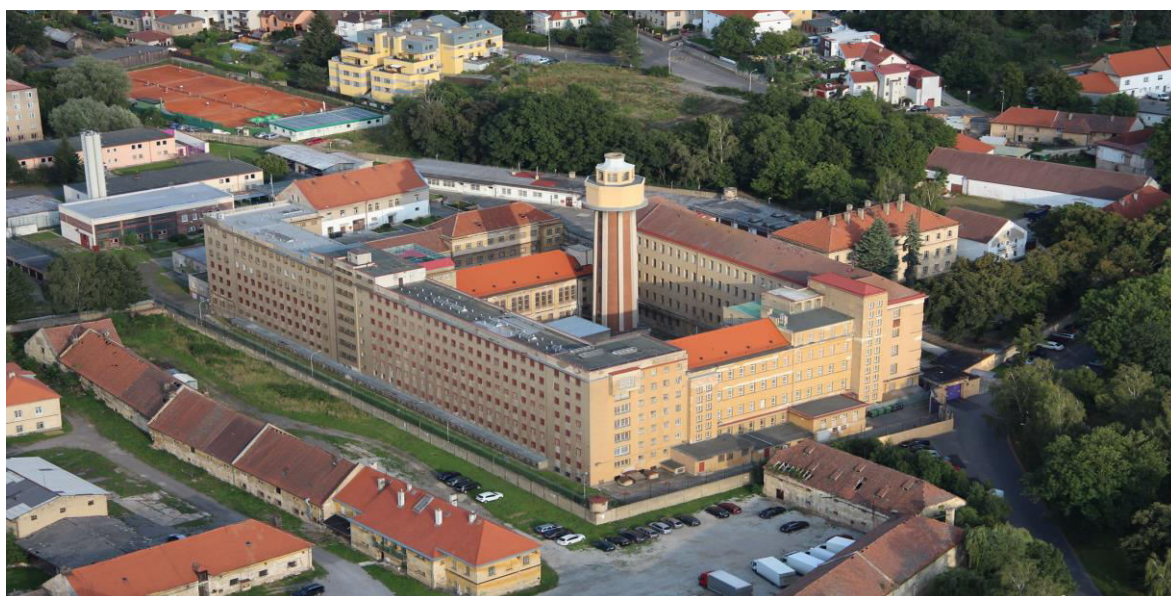
Obrázek 12 Vazební věznice Praha-Ruzyně
