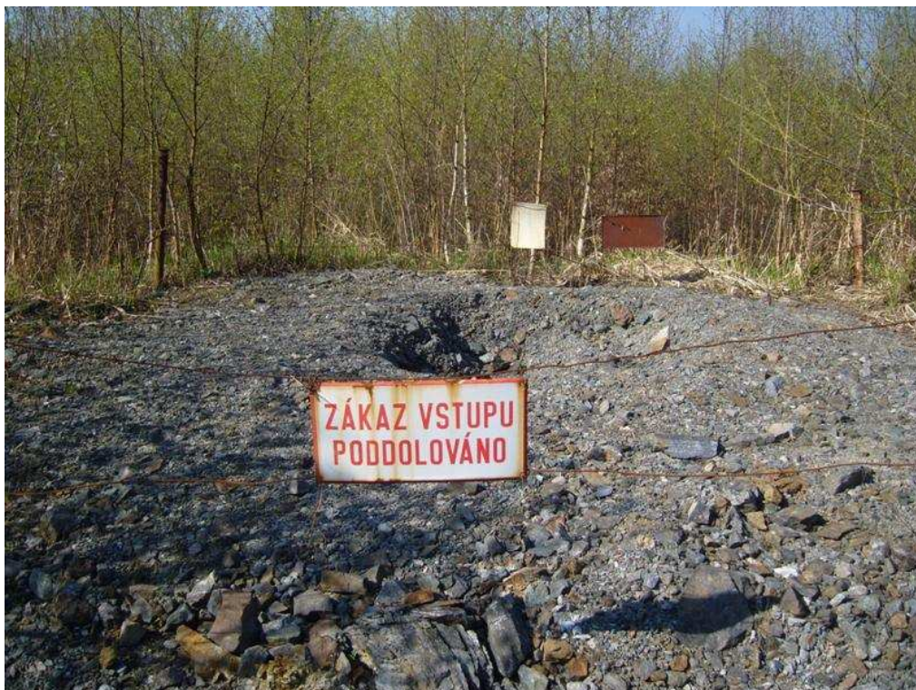
Likvidované důlní dílo zavezením (průzkumná jáma č. 35)
