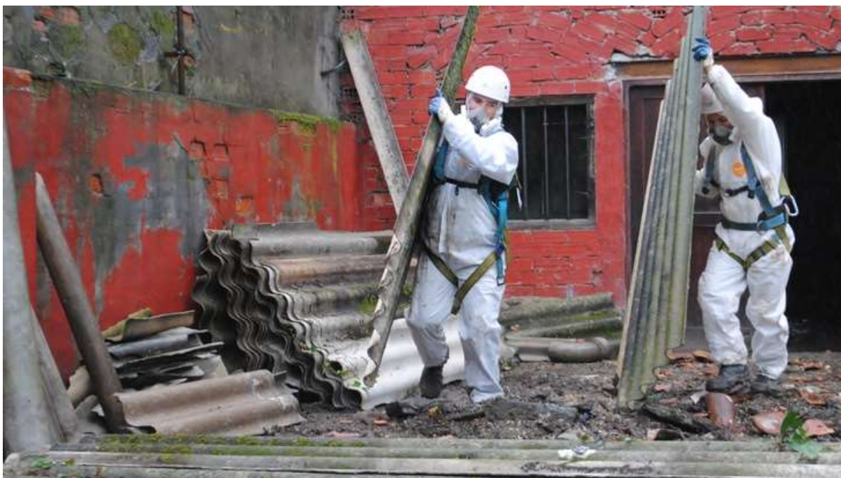
Obrázek č. 5 Manipulace s azbestem
