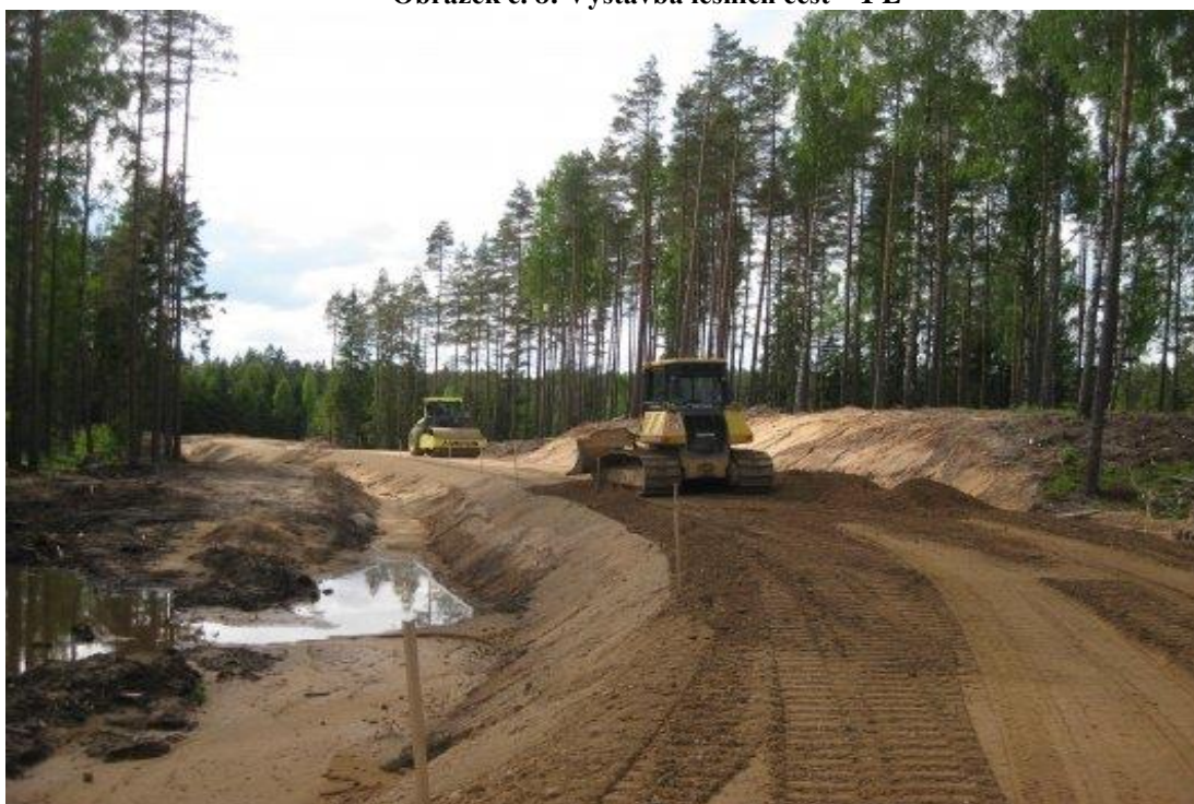
Obrázek č. 8: Výstavba lesních cest – 1 L
