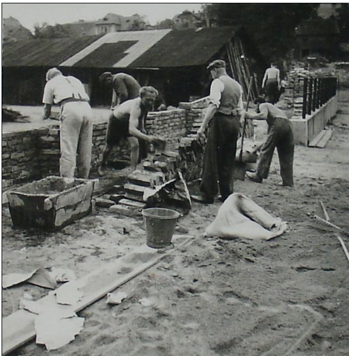
Obr. 11 Oprava zdi k Čížkům směrem od sokolovny – 1946
