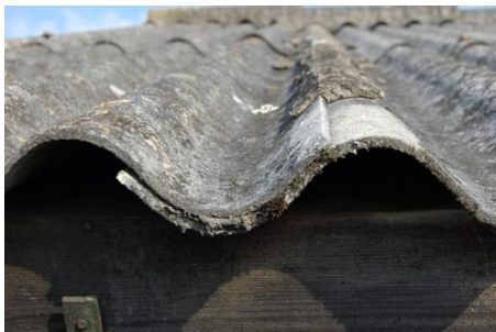
Obrázek 7.1 Vlnitá střešní krytina - eternitová
