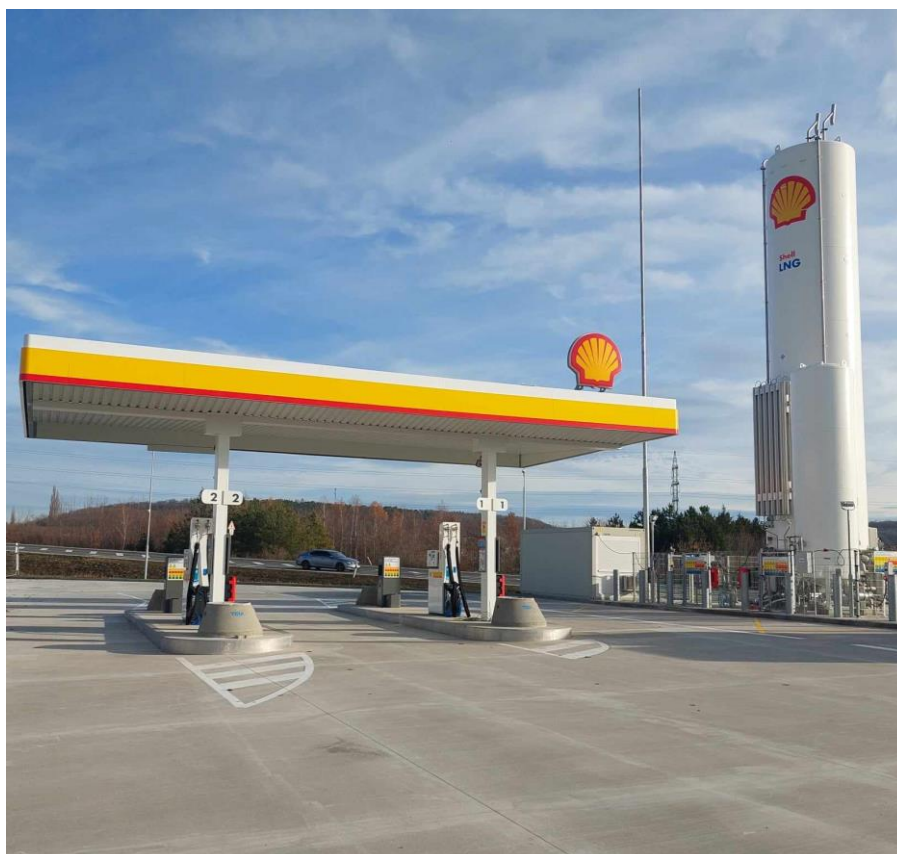
Obr. č. 3. Cementobetonový kryt u plnicí stanice LNG v Dobšicích D11 (autor, 2023)
