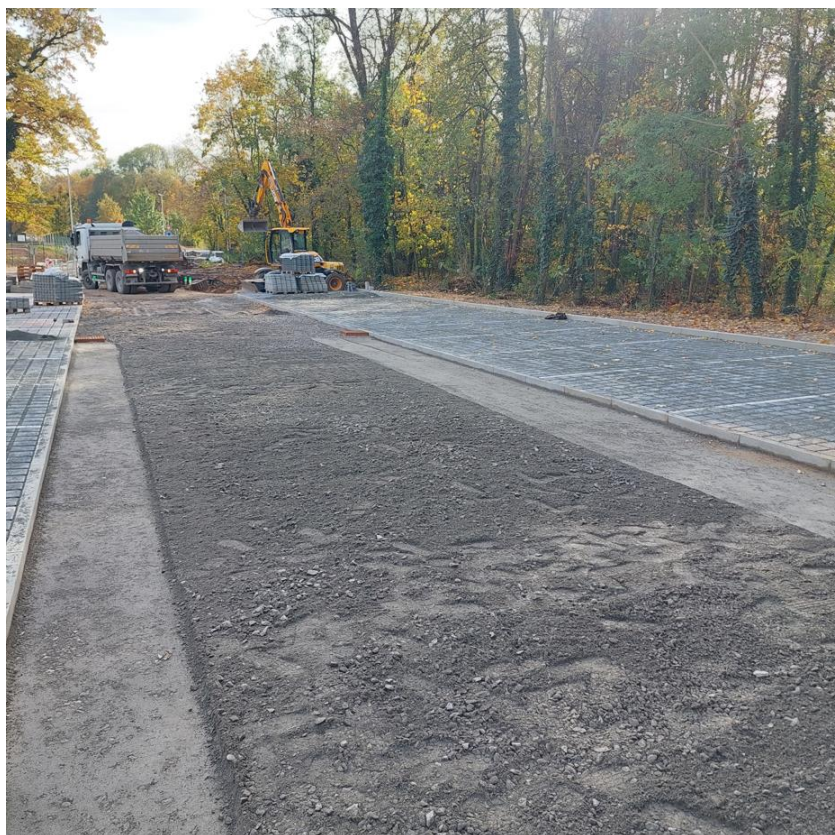
Obr. č. 4. Pokládka propustné zámkové dlažby na parkovišti Borky v Kolíně (autor, 2023)
