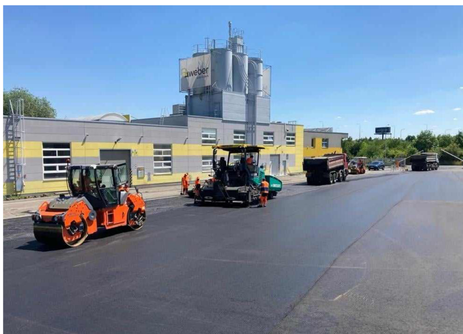
Obr. č. 2. Pokládka asfaltových vrstev v areálu firmy Weber (autor, 2021)
