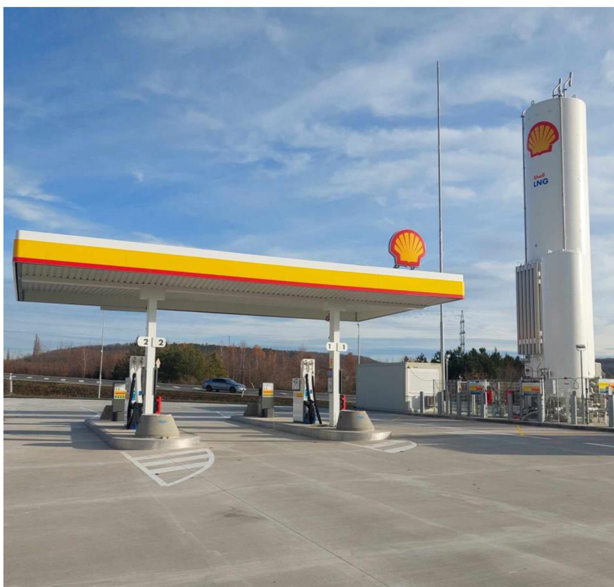
Obr. č. 3. Cementobetonový kryt u plnicí stanice LNG v Dobšičích D11 (autor, 2023)
