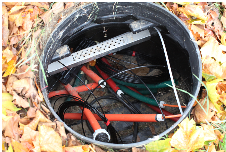
Obr. 4.16: Fotka venkovní šachty.
