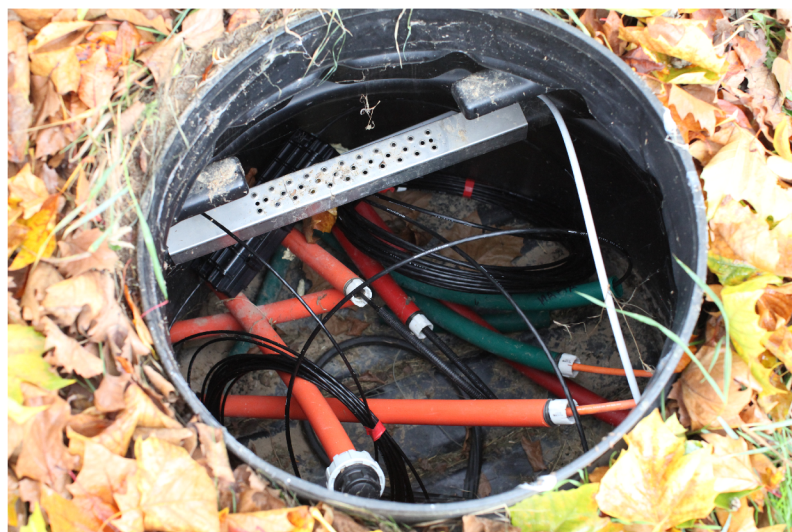
Obr. 4.16: Fotka venkovní šachty.
