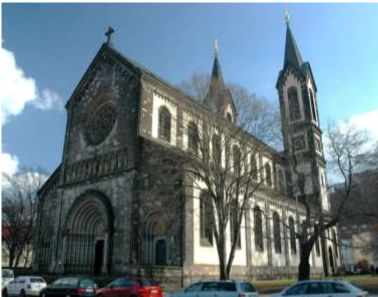
Obr. 1 Kostel sv. Cyrila a Metoděje, Praha-Karlín - vstupní průčelí
