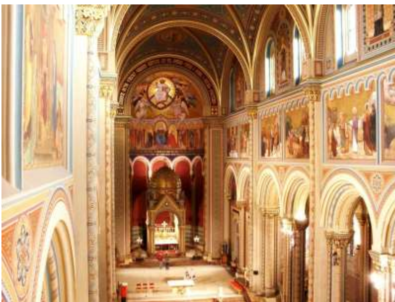
Obr. 2 Kostel sv. Cyrila a Metoděje, Praha-Karlín - interiér
