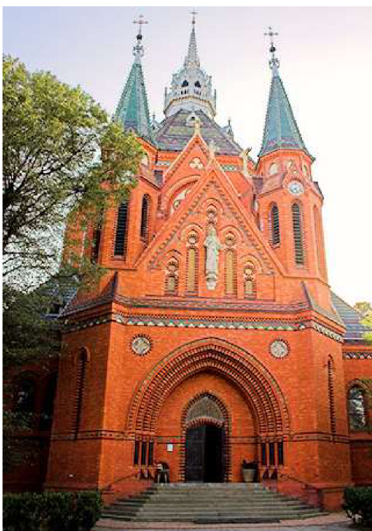
Obr. 4 kostel Navštívení Panny Marie, Břeclav-Pošterná - vstup
