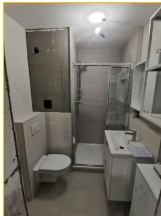
Obrázek 9 - koupelna (po rekonstrukci)
