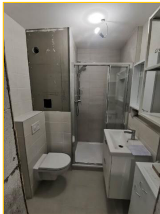
Obrázek 9 - koupelna (po rekonstrukci)
