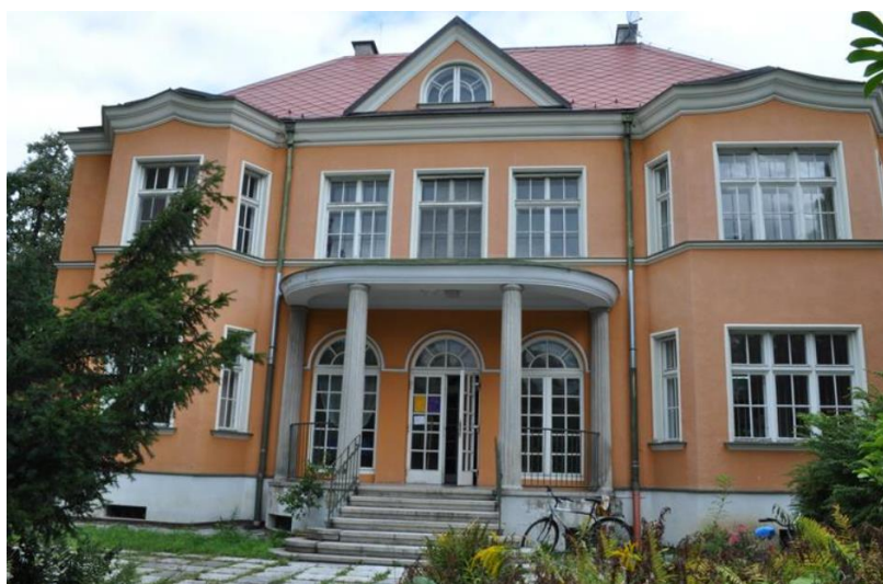
Obr. č. 23: Geiringerova vila
