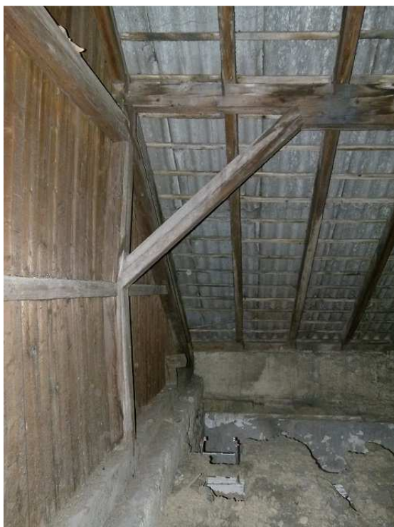
Obr.20: Krovová konštrukcie prístavby (štít krovu)
