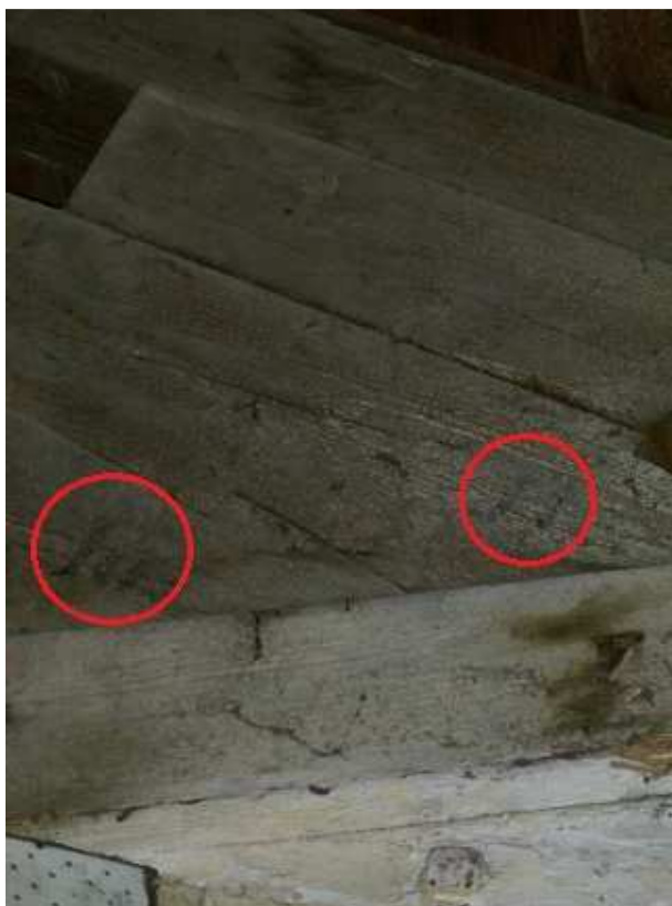
Obr.12: Tesárske značky na pätke plnej väzby
