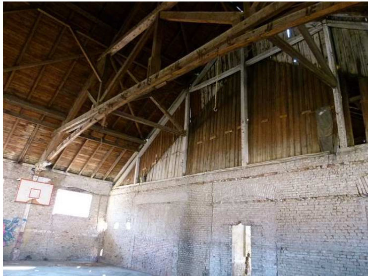
Obr.25: Juhozápadná štítová väzba (interiér)
