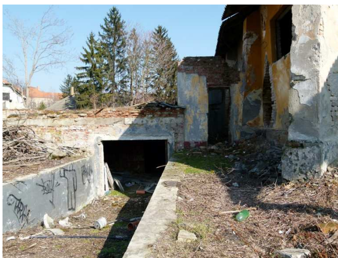
Obr.8: Suterénny objekt a časť nezastrešenej prístavby
