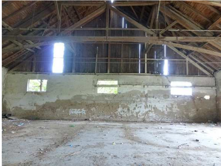
Obr.24: Severovýchodná štítová väzba (interiér)
