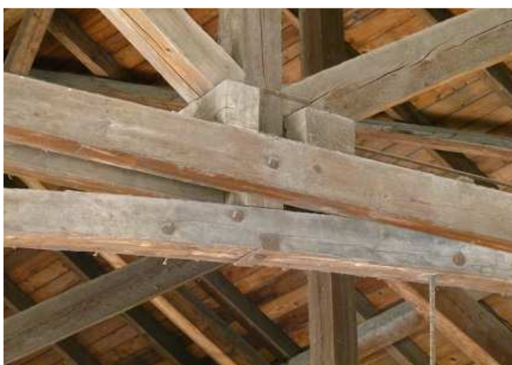
Obr.10: Detail napojenia stĺpika stojatej stolice na skruž
