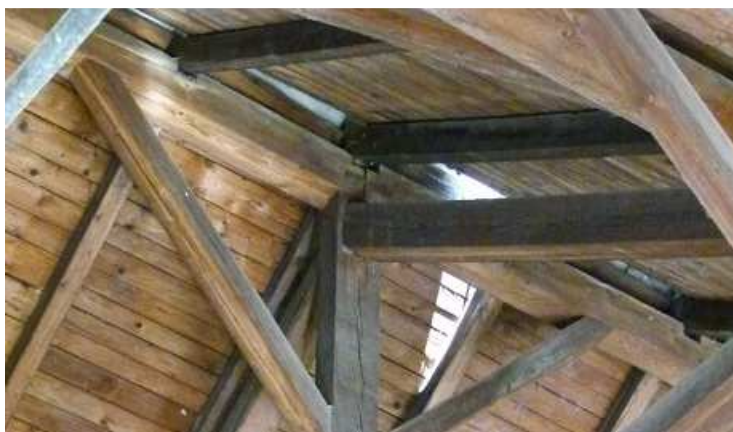
Obr.9: Hrebeňová väznica haly jazdiarne (detail napojenia)
