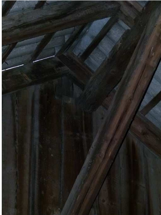
Obr.18: Napojenie hrebenevej väznice prístavby na stĺpik štítovej väzby krovu haly jazdiarne
