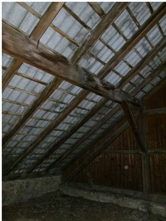
Obr.19: Krovová konštrukcia prístavby
