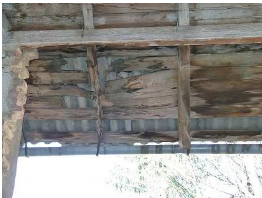
Obr.15: Poškodenie debnenia
