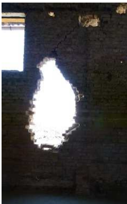
Obr.6: Poškodenie muriva
