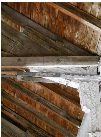
Obr.11: Pätka plnej väzby krovu haly jazdiarne
