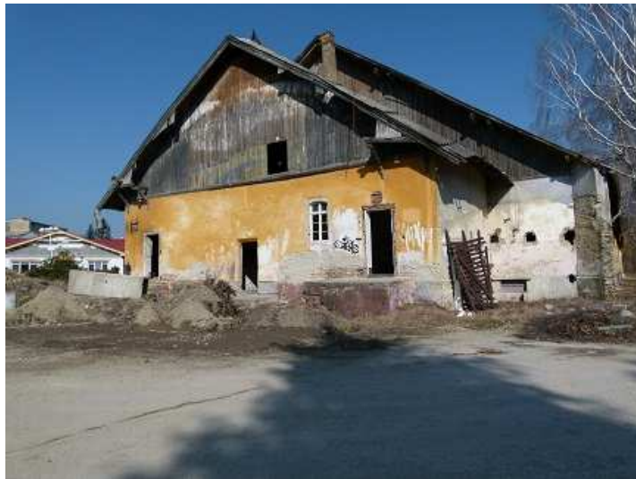
Obr.1: Pohľad na juhozápadnú fasádu budovy jazdiarne
