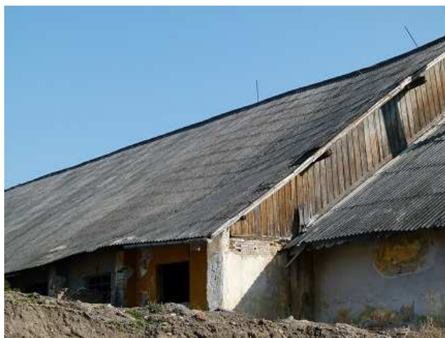
Obr.7: Pohľad na juhozápadnú časť strechy
