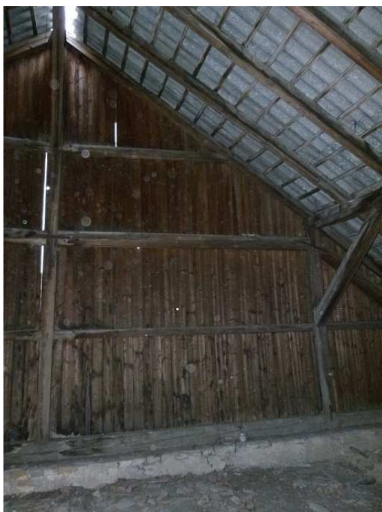
Obr.21: Krovová konštrukcie prístavby (podobnosť so severovýchodným štítom haly jazdiarne)
