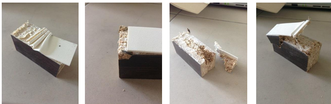
Obr. 49; 50; 51; 52 príklady extrémnych poškodení na DTD a ABS
