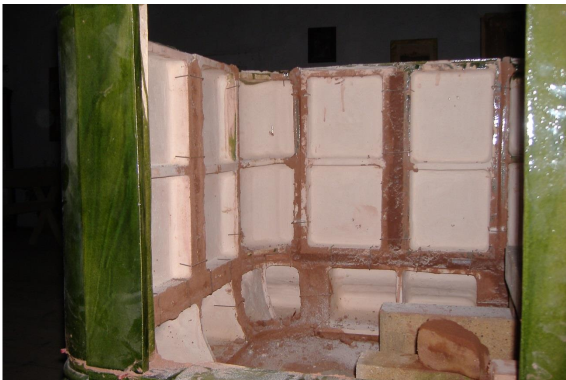
Obr. 13. – Výstavba soklové části kachlových kamen.
