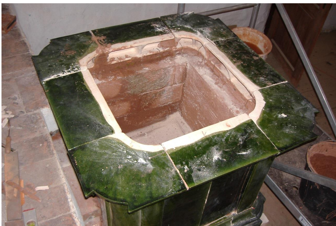
Obr. 14. – Zpevnění kachlových kamen šamotovými cihlami.
