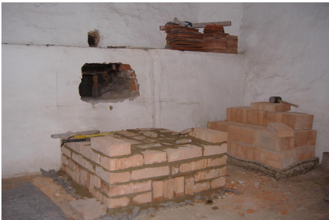
Obr. 12. - Výstavba soklu pod kachlovými kamny.
