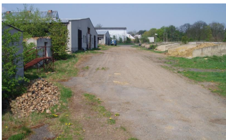
Foto č. 6 Komunikace v zem. areálu – jižní pohled
