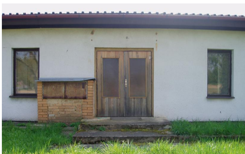
Foto č. 18 Objekt B – stávající stav (severní pohled)
