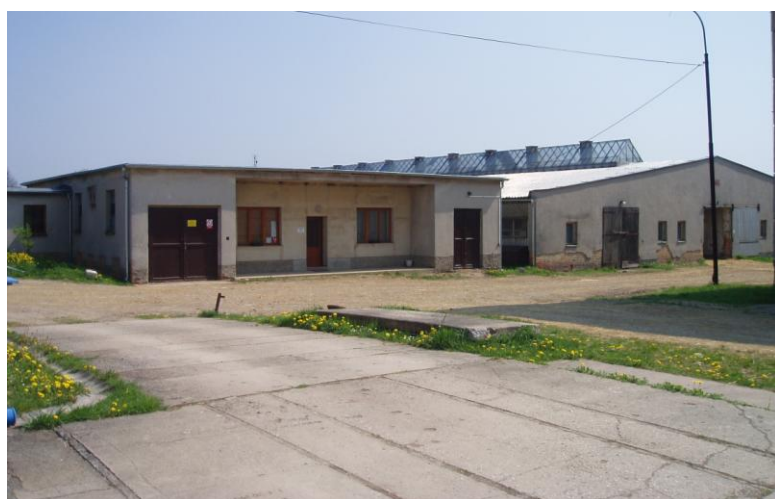
Foto č. 9 Objekt K - stávající stav (západní pohled)
