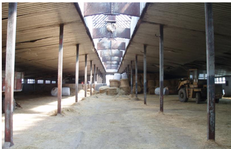
Foto č. 10 Objekt J – stávající stav (stájové prostory)
