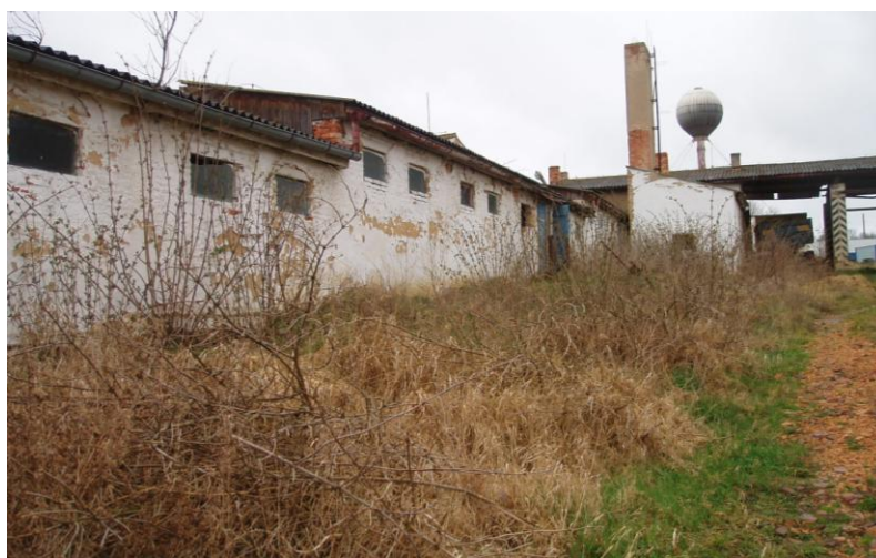
Foto č. 12 Objekty P,Q – stávající stav (jihovýchodní pohled)
