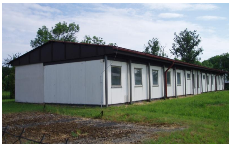
Foto č. 15 Objekt B – stávající stav (jihozápadní pohled)
