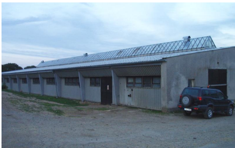
Foto č. 7 Objekt J - stávající stav (severozápadní pohled)
