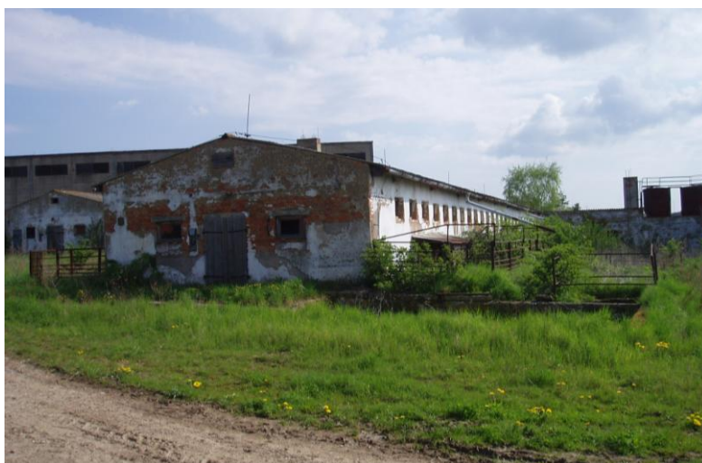
Foto č. 11 Objekty P,Q – stávající stav (západní pohled)
