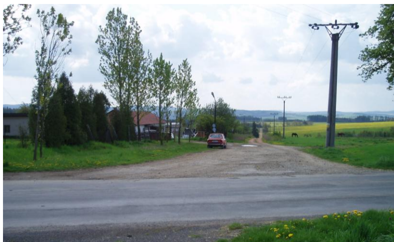
Foto č. 4 Polní cesta a její napojení na silnici II. třídy - severní pohled
