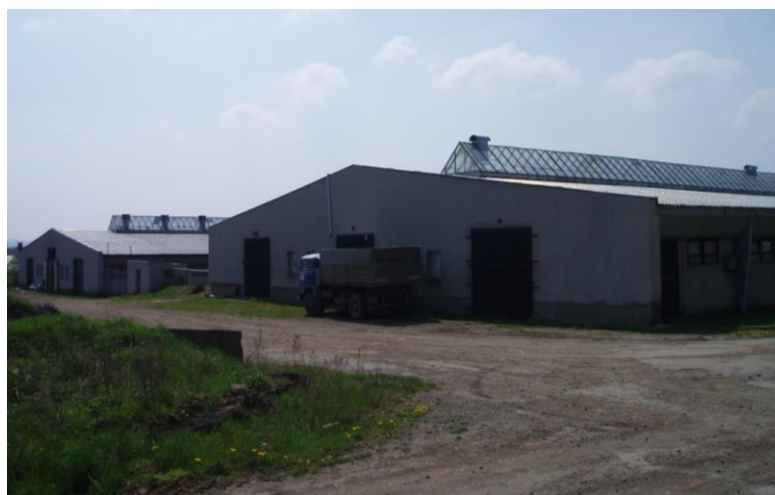
Foto č. 8 Objekt J – stávající stav (severozápadní pohled)
