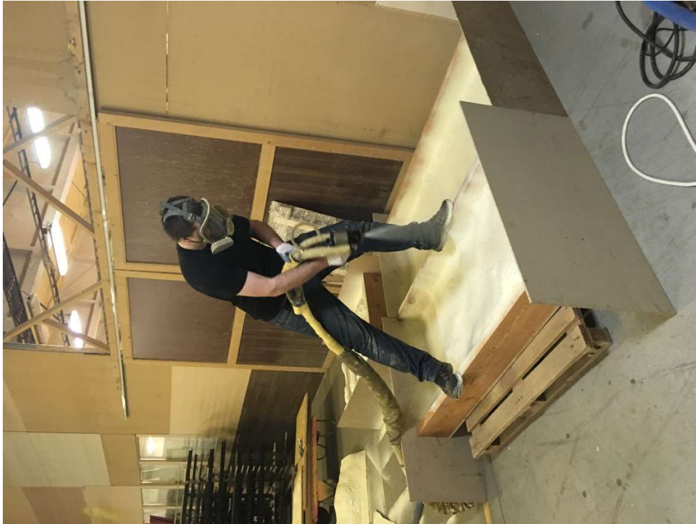
Obr. č. 23 Stříkání pěny s otevřenou strukturou buněk.
