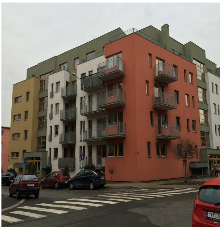
Obr. 4 Bytový dům Praha-Hloubětín. Foto: Smolný
