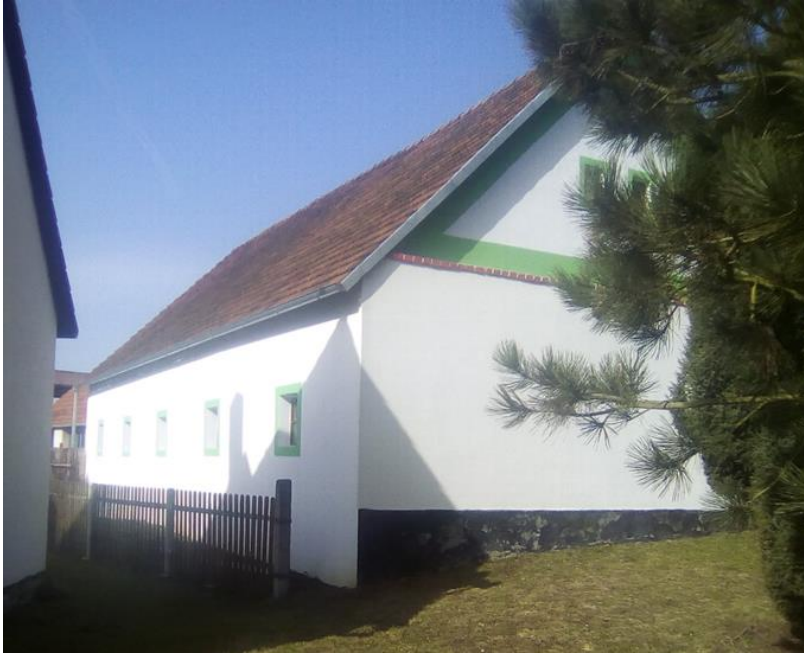
Obrázek č. 1: Budova stáje pro skot
