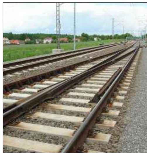
Obr. 6 Zkušební úsek Planá nad Lužnicí, výhybka č. 11 bez USP, pohled ve směru staničení [5]
