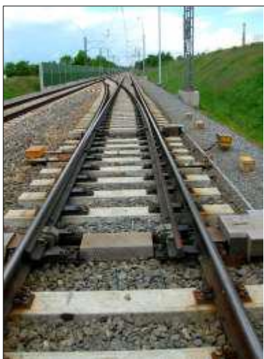
Obr. 5 Zkušební úsek Planá nad Lužnicí, výhybka č. 12 s USP, pohled ve směru staničení [5]
