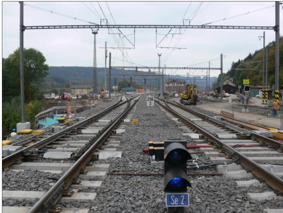
Obr. 11 Výhybka č. 7 a 8, pohled do stanice [8]
