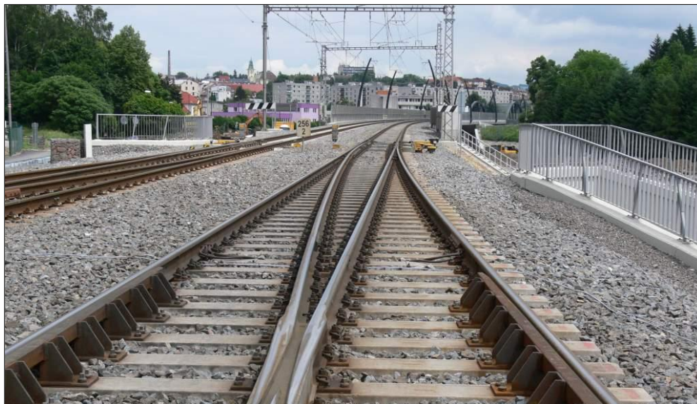
Obr. 10 Výhybka č. 7, pohled ze stanice [8]
