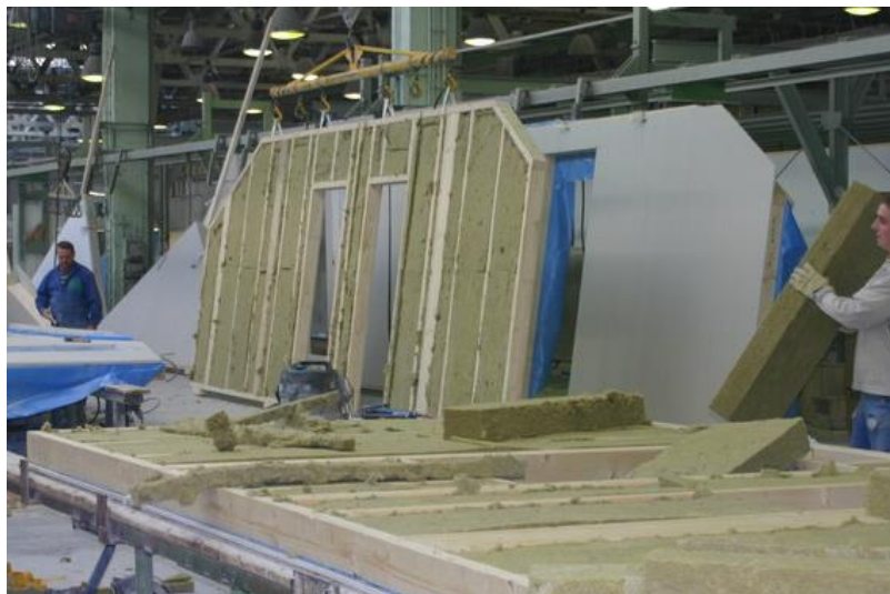
Obr. 3 - Vyplňování rámu tepelnou izolací (RD Rýmařov)
