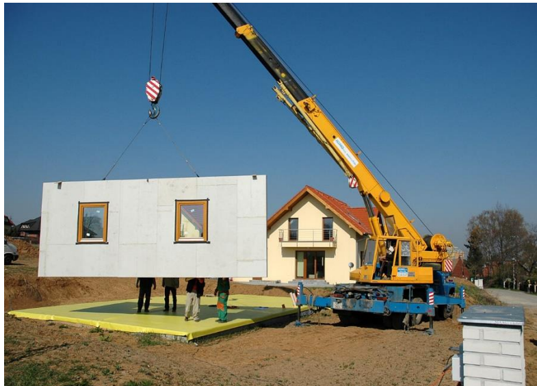
Obr. 5 - Osazování prefabrikovaných panelů na staveništi (Domy D.N.E.S. s. r. o.)
