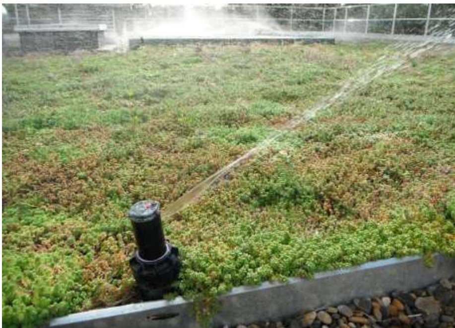
Obr. 21 Horní závlaha zelených střech [51]
