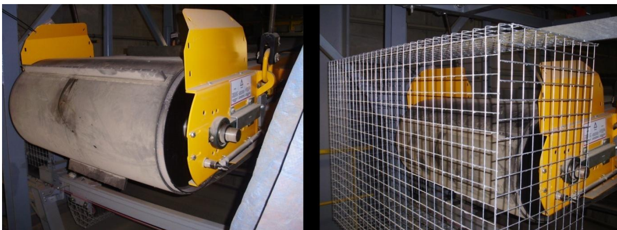
Obr. 23 Montáž ochranného krytu nadpásového magnetického separátoru
