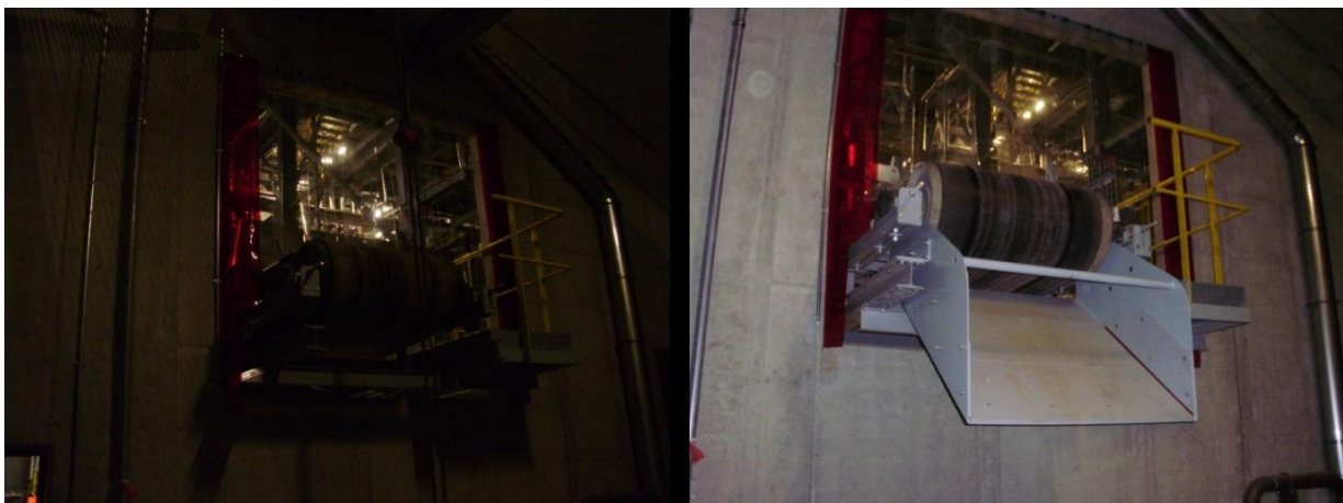
Obr. 24 Montáž skluzu na pásový dopravník PD100-4600
