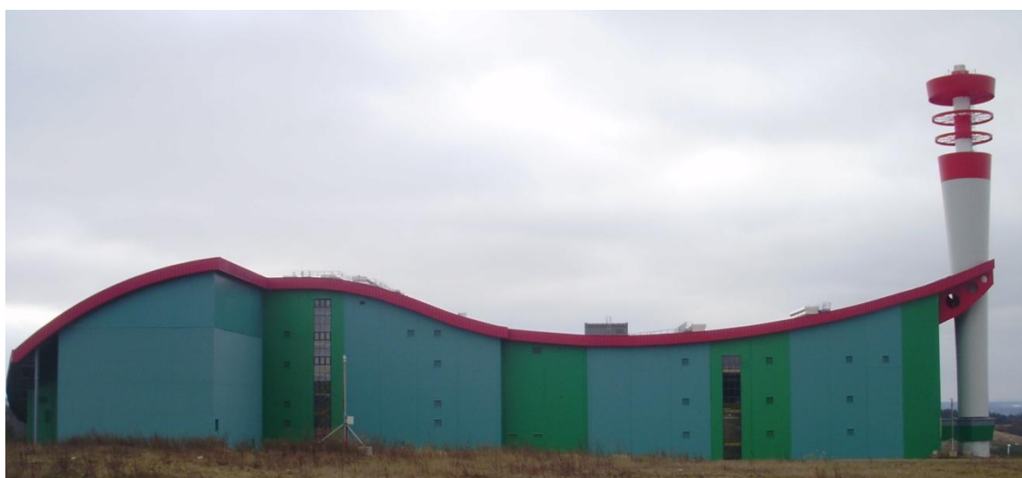
Obr. 18 Závod energetického využití komunálního odpadu v Chotíkově u Plzně
