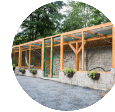
Obr. 117. Záchraná stanice Pavlov
