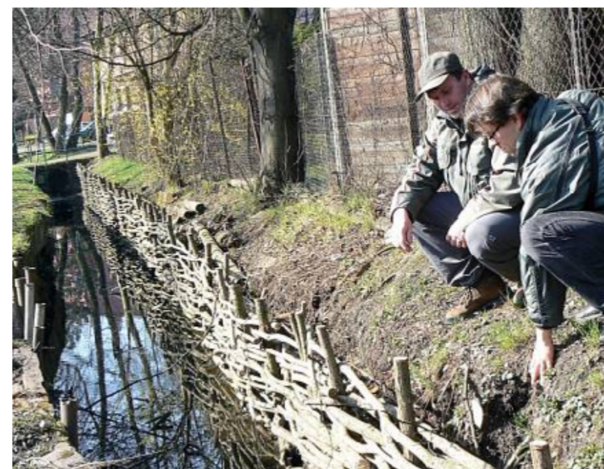
Obr. 64. Zpevnění břehu vrbovým proutím ( https://karvinsky.denik.cz )
