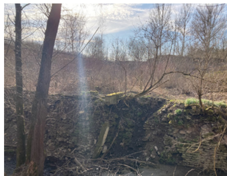
Obr. 132. Pohled před potokem na ruderální porost na severní straně pozemku, zachycena i poničená zídka zpevňující břeh
