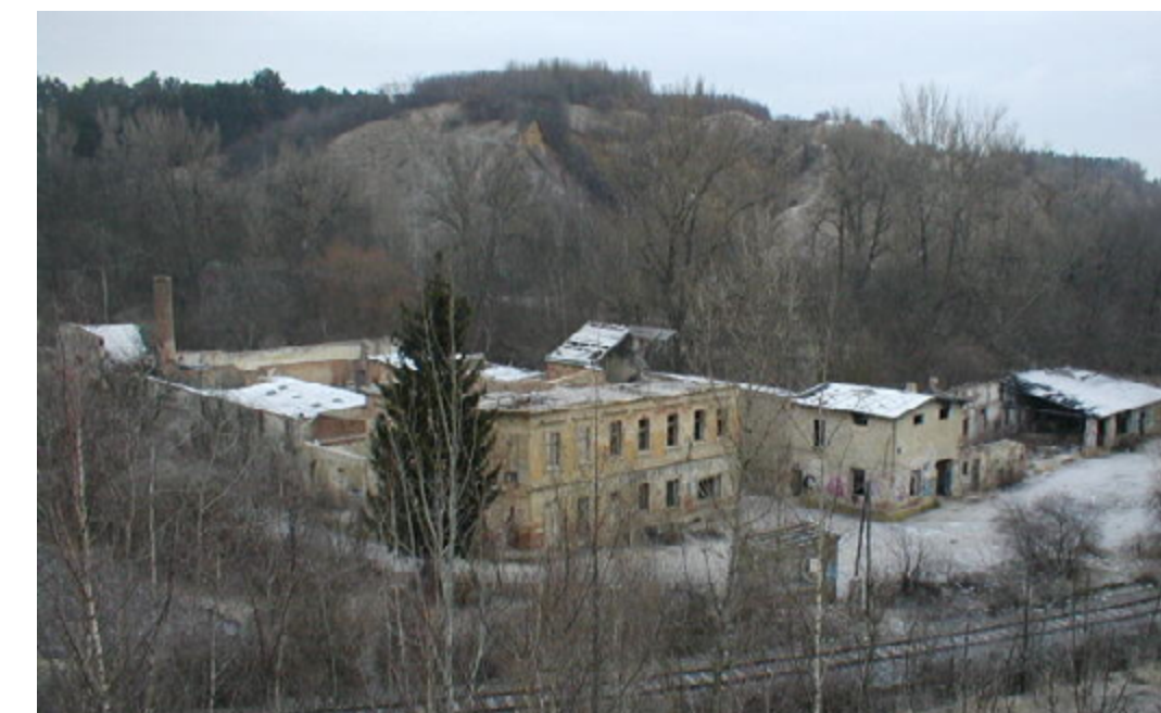
Obr. 75. Stav vápenky v roce 2005 ( http://podzemi.solvayovylomy.cz )
