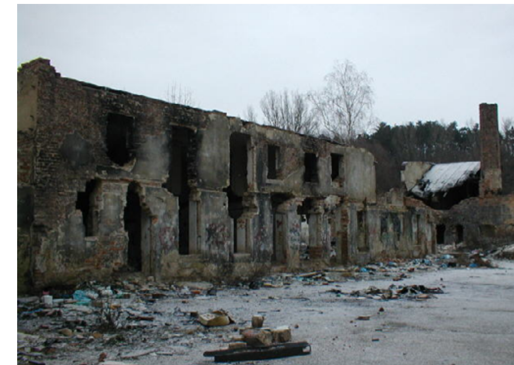
Obr. 74. Stav vápenky v roce 2005 ( http://podzemi.solvayovylomy.cz )
