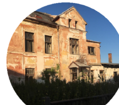
Obr. 16. Bývalý objekt lehkého průmyslu Středočeský kraj
