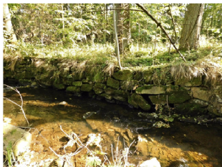
Obr. 63. Zpevnění břehu kombinací kamenné zdičky a stromů ( https://www.vodnimlynky.cz )
