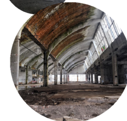
Obr. 14 a 15. Bývalý objekt těžkého průmyslu kraj Praha
