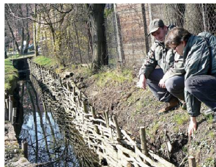
Obr. 64. Zpevnění břehu vrbovým proutím ( https://karvinskydenik.cz )
