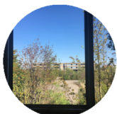
Obr. 5. Bývalý vojenský objekt - kasárny kraj Praha
