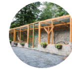
Obr. 117. Záchranná stanice Pavlov
