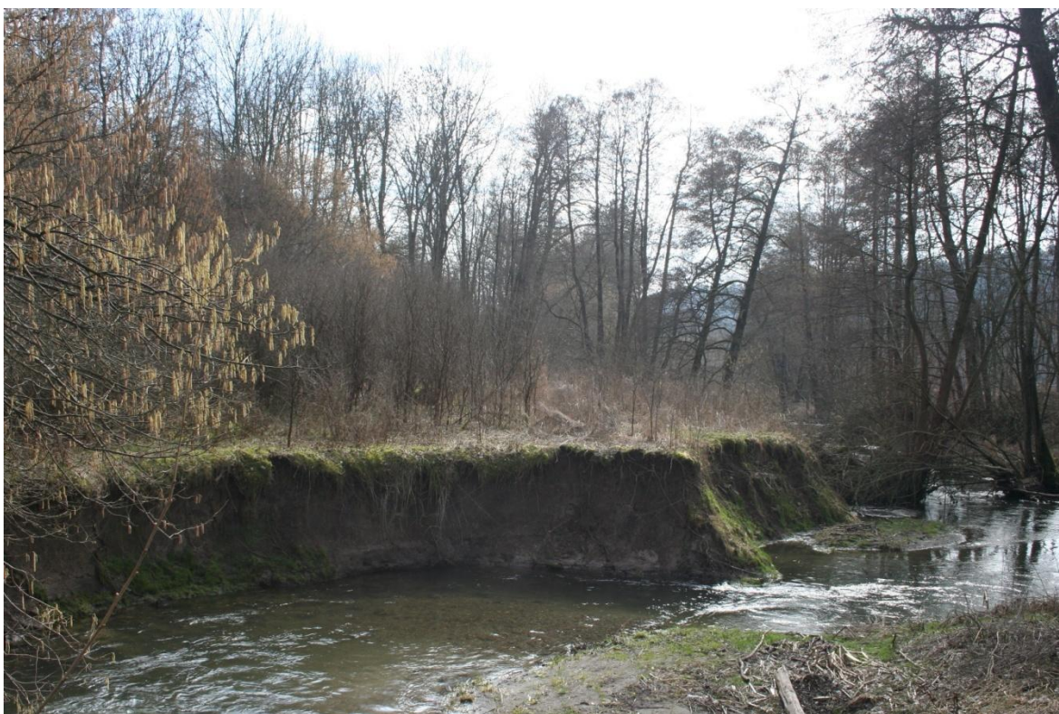
Fotografie 10: Maliník není schopen břehy stabilizovat a vzniká velký abrazní srub (autor)
