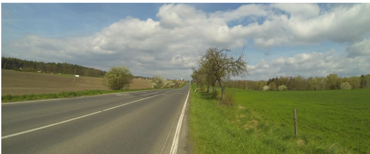
Obrázek 20: Silnice II/268 Mnichovo Hradiště – Bílá Hlína (zdroj: Vlastní foto)
