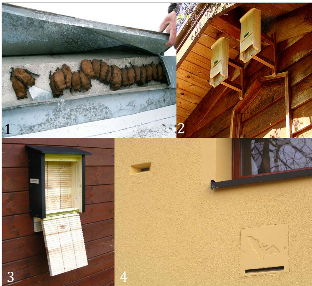
Obr. 43 Odkrytí hibernujících netopýrů při rekonstrukci střechy, foto: Radek Lučan (zdroj: http://stavba.tzb-info.cz/zelena-usporam-na-tzb-info/6565-zatepovani-pod-jednou-strechou-s-rorisy-a-netopyry-i-panelove-domy ), 2 Umístění budek ve štítě (zdroj: http://aa.ecn.cz/img_upload/e6ffb6c50bc1424ab10ecf09e063cd63/budkapronetopyry7.jpg ), 3 Otevřená netopýří budka (zdroj: http://www.zelenadomacnost.com/data/images/3609.jpg ), 4 úkryt pro netopýry v nově zateplené budově (zdroj: http://www.zelenadomacnost.com/data/images/1229.jpg )
