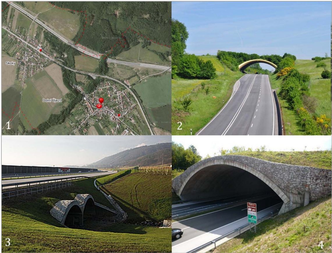
Obr. 39 Příkladů ekoduktů – 1 Letecký snímek nefunkčního ekoduktu R35 u Dolního Újezdu na střední Moravě (zdroj: http://www.mapy.cz/letecka?source=muni&id=96&q=Doln%C3%AD%20%C3%BAjezd&l=0&x=17.537087&y=49.549907&z=14 ), 2 Birkenau, Germany (zdroj: http://www.wimp.com/uniquebridge/ ), 3 Kombinovaný most (zdroj: http://www.hbh.cz/ekologicke-stavby/ ), 4 Funkční 120 metrů široký ekodukt „Ivačevo Brdo“ v Chorvatsku je příkladem skloubení požadavků ochránců přírody a stavařů. (zdroj: http://www.selmy.cz/ohrozeni/migracni-koridory/ekodukty-v-chorvatsku/ )
