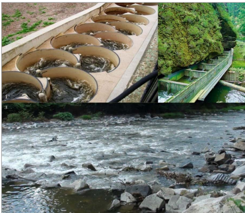
Obr. 18 - 1 Technický rybí přechod ze sklolaminátových trub (zdroj: http://www.hobas.cz/uploads/pics/fishladder_44.jpg ) 2 Technický rybí přechod řeší zprostřednění jezu v obtížných podmínkách kaňonu říčky Kamenice, Národní park České Švýcarsko. Foto P. Birklen (zdroj: http://www.casopis.ochranaiprirody.cz/Z-nasi-prirody/reseni-migracni-prostupnosti-ricni-site-v-cr.html ), 3 Balvanitý rybí přechod v Ostravicích, foto Josef Jágr, 2014
