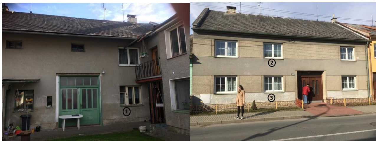
Obr. 15 Fotografie s označením míst měření
