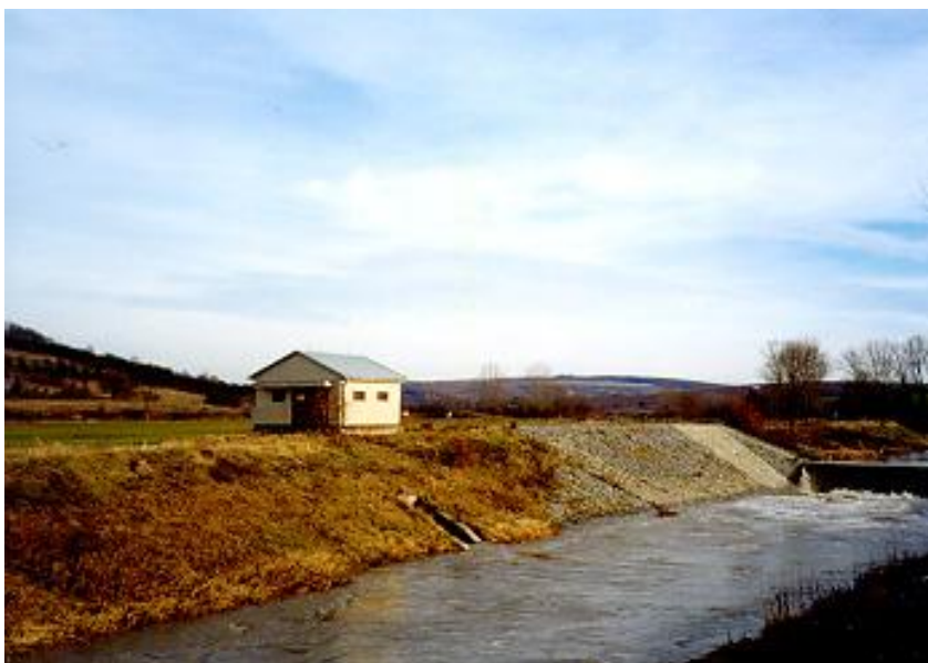
Obr. 12: Malá vodní elektrárna na řece Olšavě (zdroj: atlas zařízení využívajících OZE, online, 2014)
