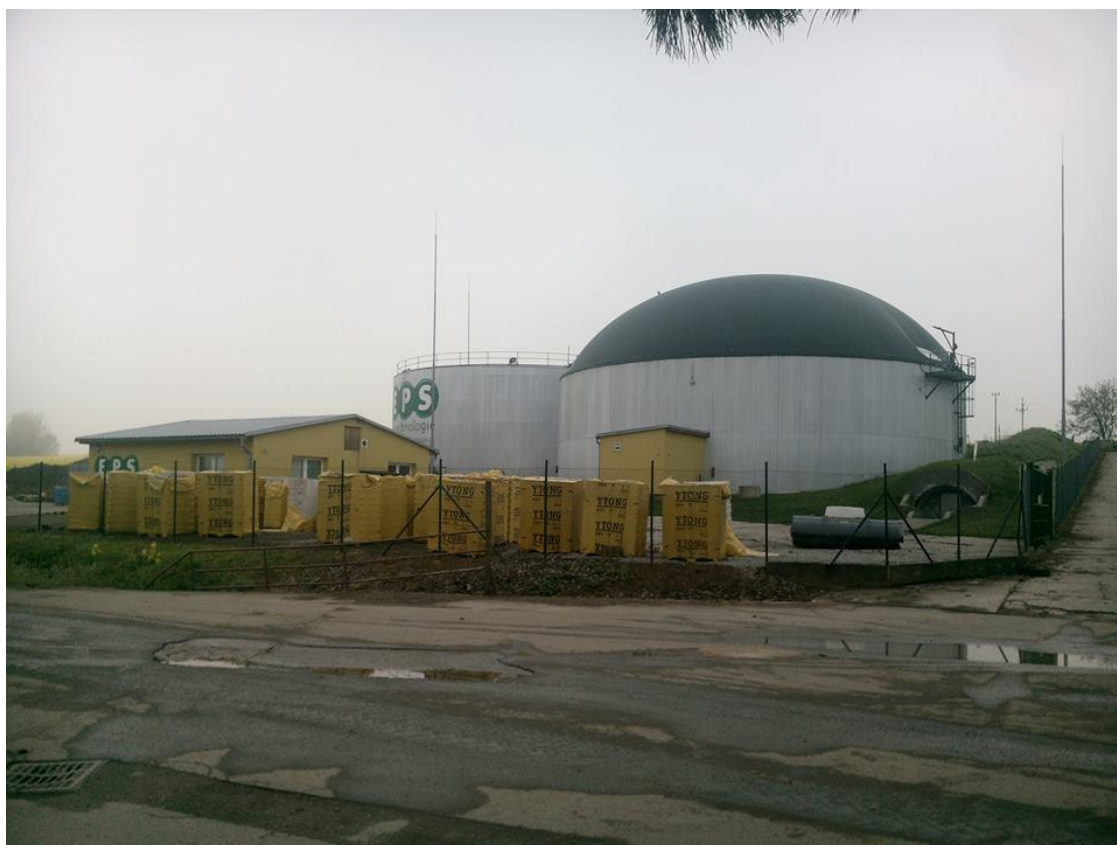
Obr. 10: Bioplynová stanice v Kunovicích (zdroj: vlastní foto)
