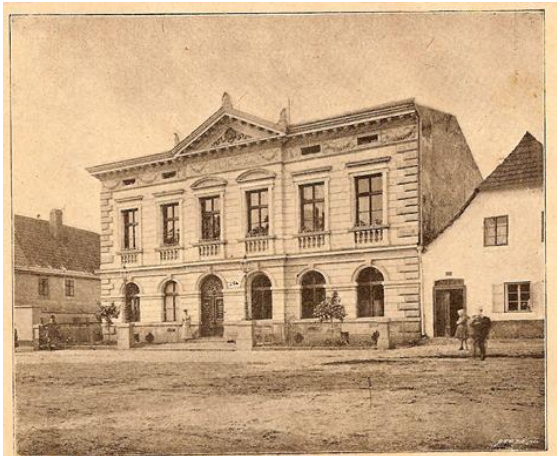
Obr. č. 5 Školní budova v Bělé pod Bezdězem, závěr 19. století
