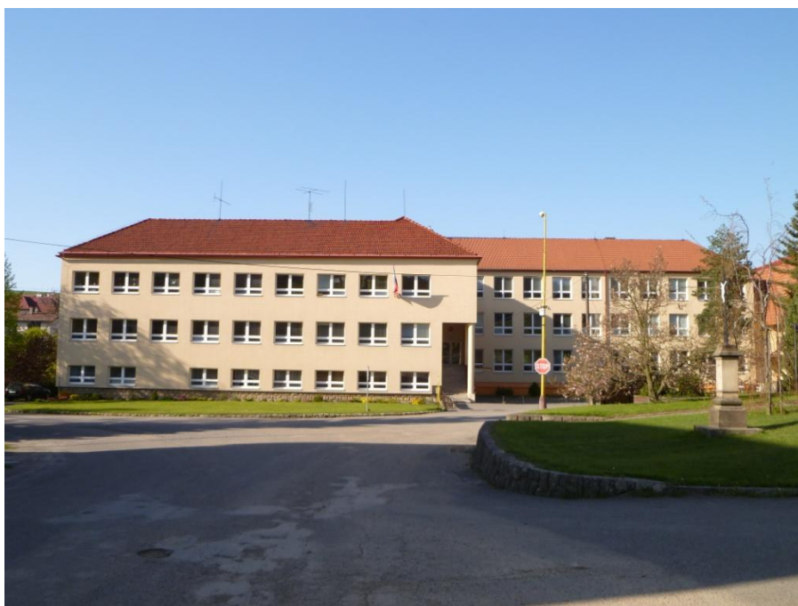
97. Školní budova ve Vidči čp. 181, Bohumír Kupka, 1939 – 1940. Dnešní stav. Foto: autorka.
