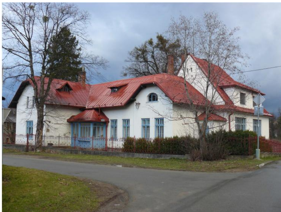
74. Jaroňkova vila, Čechova ulice čp. 518, přestavba Antonín Blažek, 1924. Dnešní stav. Foto: autorka.
