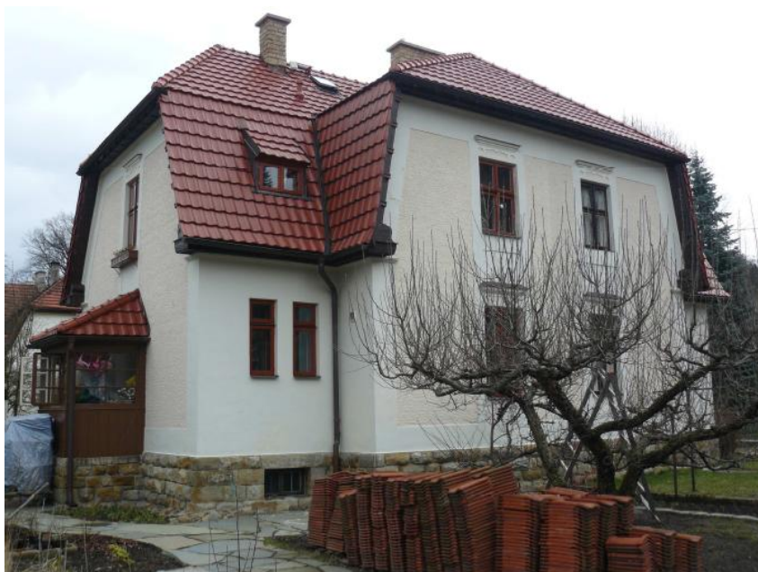
85. Rodinný dům, Bučiska čp. 617, Jan Kotěra, 1922-1924. Dnešní stav. Foto: autorka.
