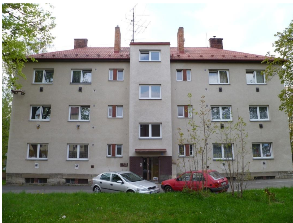
45. Obytné domy s malými byty, Rožnovská čp. 1182-1185, Josef Horáček, 1940. Dnešní stav. Foto: autorka.
