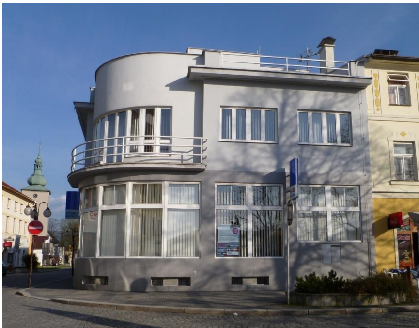
22. Budova Městské spořitelny, náměstí Míru čp. 29, Oskar Poříška, 1930. Dnešní stav. Foto: autorka.
