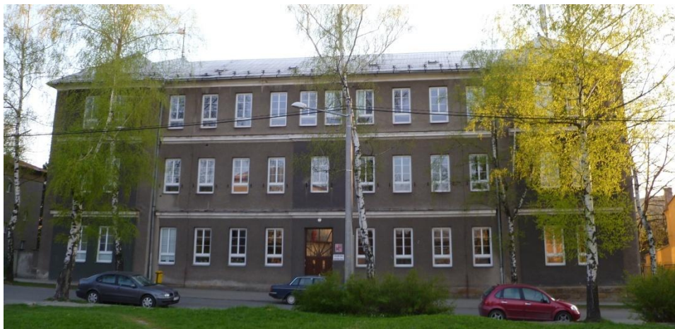
9. Budova tkalcovské školy, Tyršova čp. 913, Alfréd Parma, 1904. Dnešní stav. Foto: autorka.
