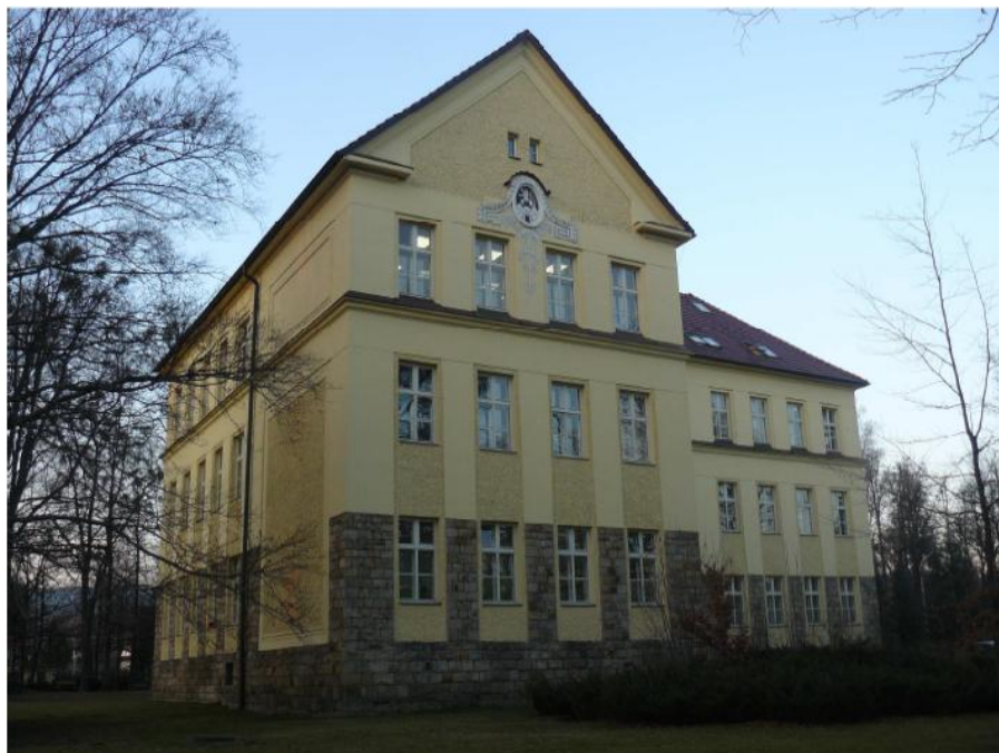
78. Měšťanská škola, Pionýrská ulice čp. 20, Vladimír Fischer, 1914-1919. Dnešní stav. Foto: autorka.
