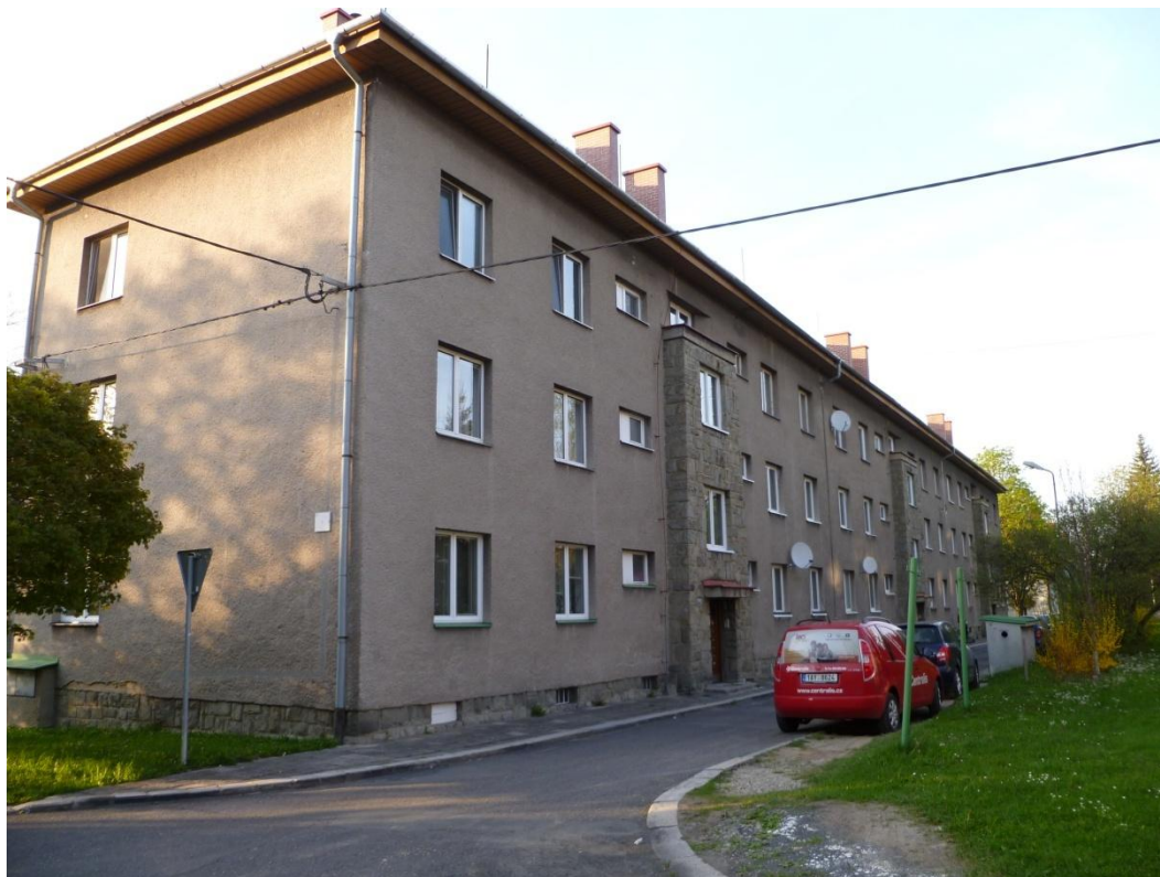
53. Bytové domy pro podnik MEZ, Beskydské sídliště čp. 1187 – 1204, Bohuslav Fuchs, 1948. Dnešní stav. Foto: autorka.
