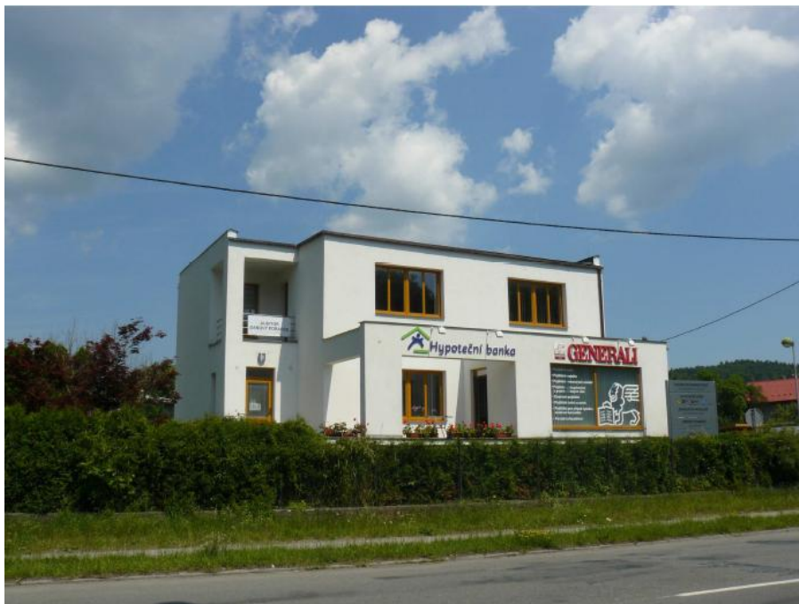
90. Vila Adolfa Novotného, Nábřeží dukelských hrdinů čp. 561, Vít Obrtel, 1927-1928. Dnešní stav. Foto: autorka.
