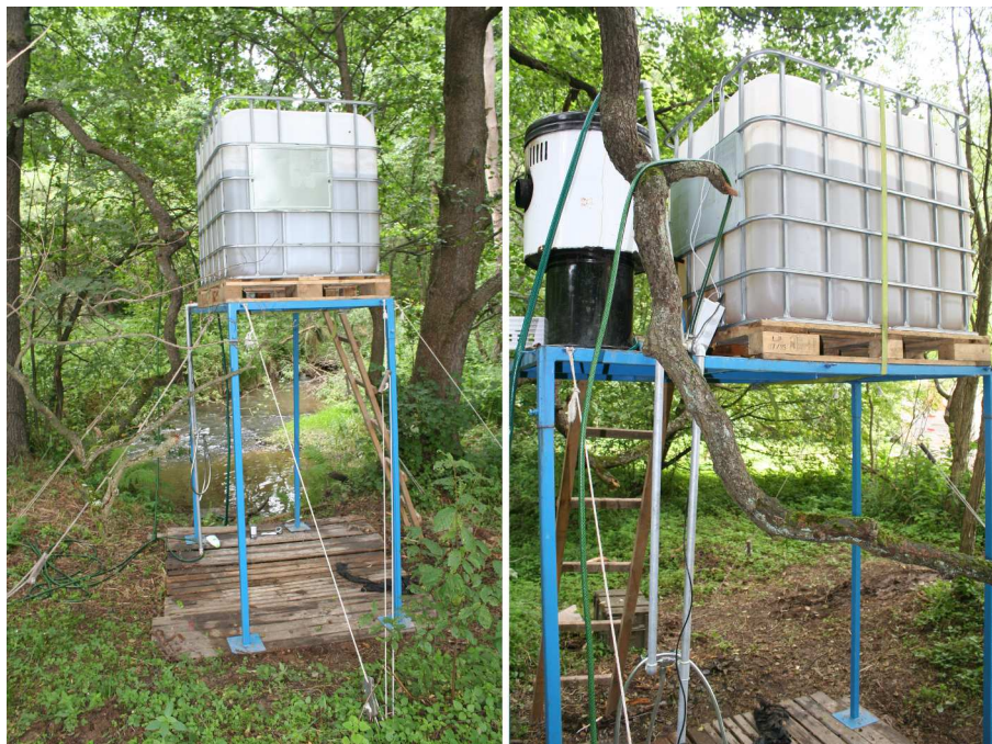
Obrázek 6.4: Konstrukce sprchy se zásobní nádrží
