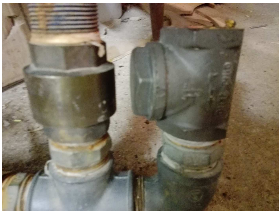
Obrázek 5.8: Detail klapky „vysokého“ trkače 1 1/4" na 1/2"
