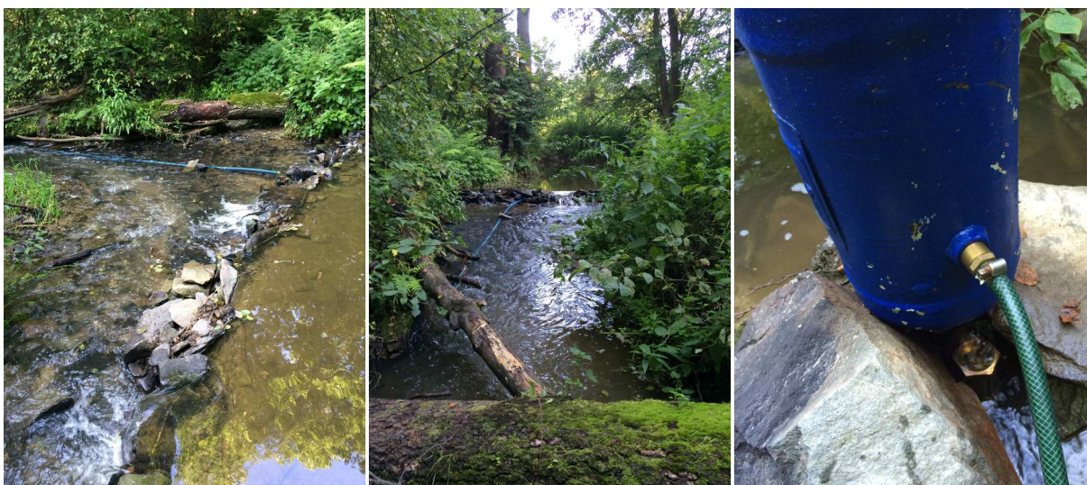
Obrázek 6.2: Napojení vodního trkače do Trusovického potoka
