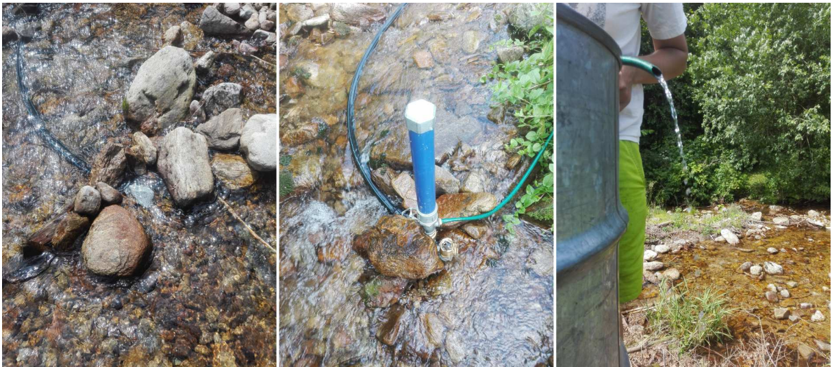
Zleva: vtoková část přívodního potrubí, osazení vodního trkače, čerpané množství vody a zásobní nádrž
