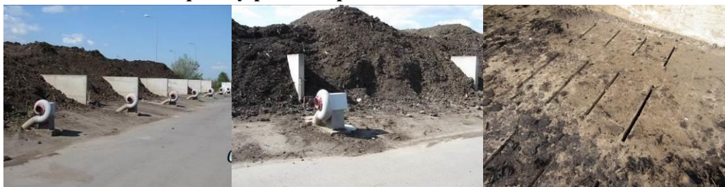
Obrázek 46 Provzdušňování – panely pod kompostovací hromadou (Zdroj: a, b - Karhánková, I., c - Černovice, Žabčice, Podivín, 2012)
