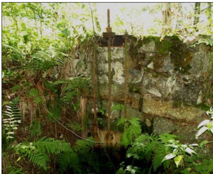
Opatření č. 2 - revitalizace koryta bezejmenného pravostranného přítoku Jeřice
