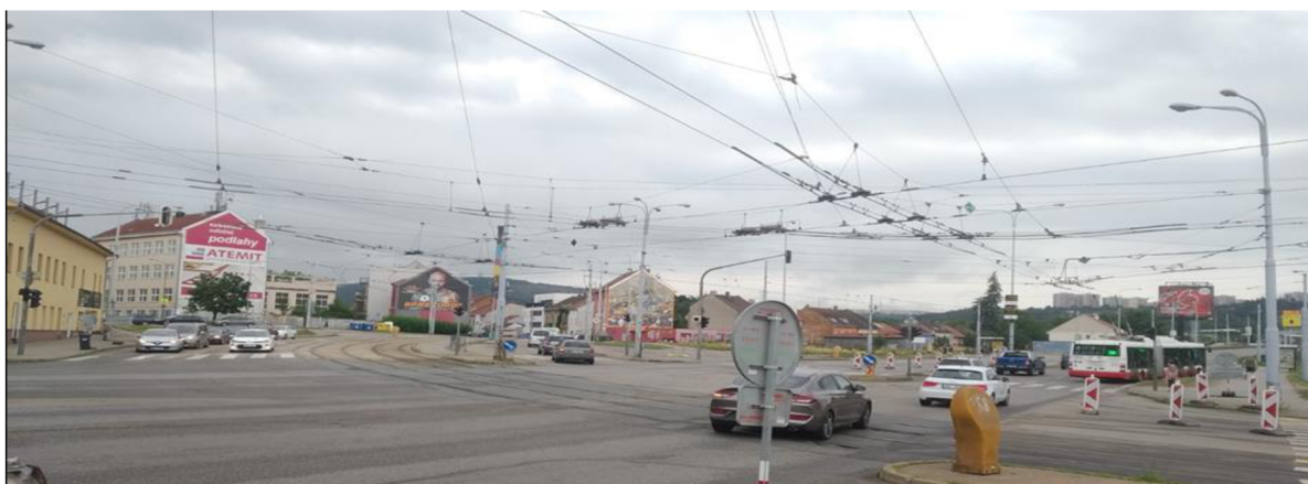
Obr. č. 10: Tomkovo náměstí Brno před zahájením stavby
