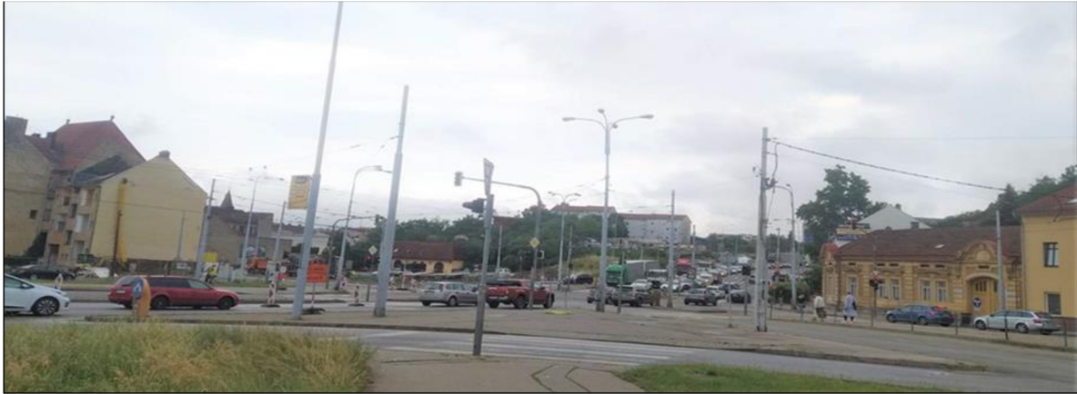
Obr. č. 9: Tomkovo náměstí Brno před zahájením stavby
