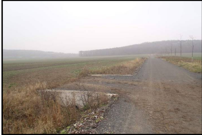
Obrázek 17 Cesta HPC1, hospodářský sjezd s propustkem, foto Soukenka, podzim 2011.
