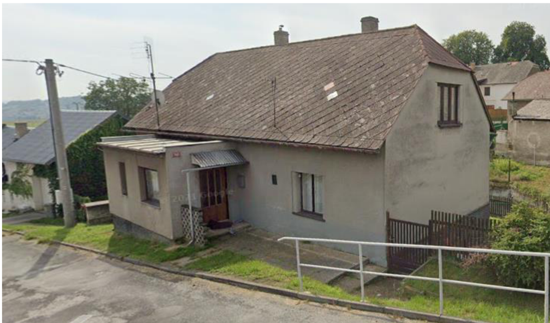
Obrázek 4 Stav před zahájením stavebních úprav [16]
