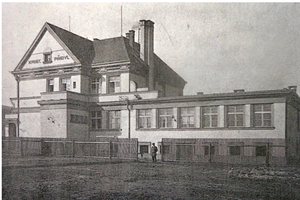
41. Kancelářská budova firmy Krbec a Příbyl, Bratří Hubálků 1230, Jan Duchoslav, 1925.
