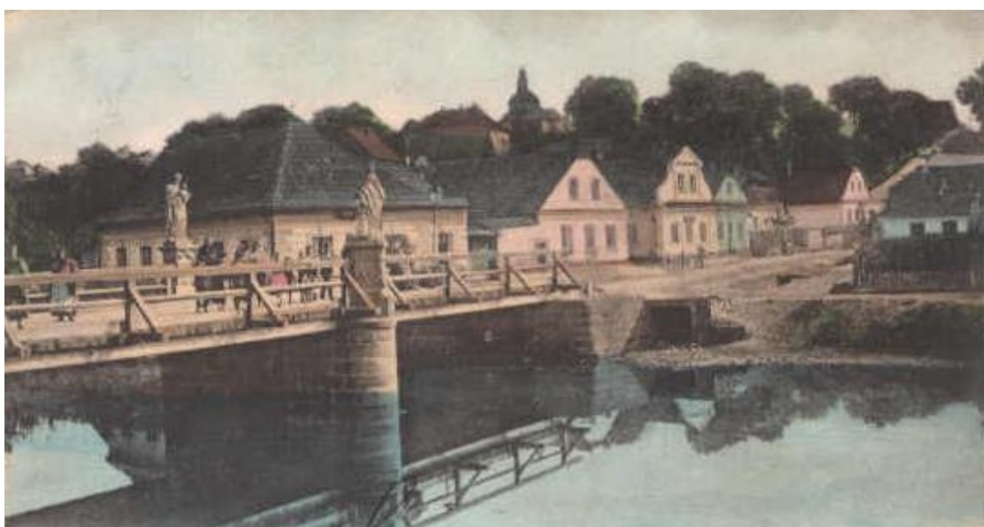
5. Záměstí, původní most přes Třebovku osazený barokními sochami, stav roku 1902.
