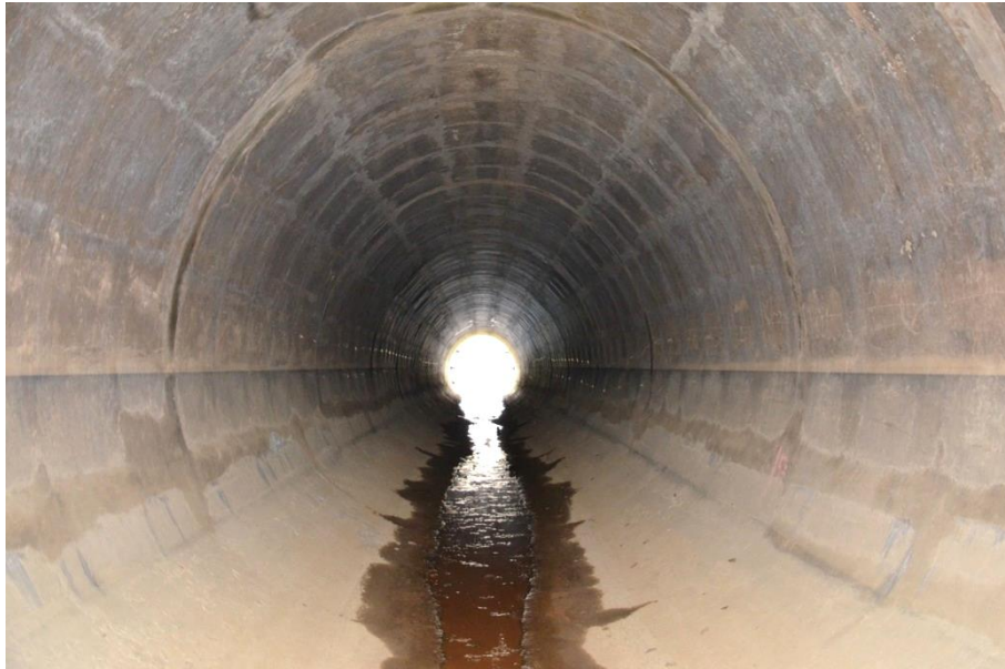
Obr. 40 – Podélné a příčné pracovní spáry v tunelu
