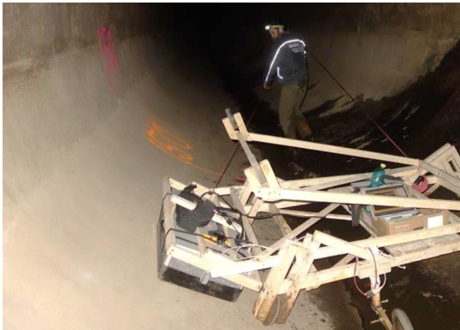
Obr. 39 – Měření metodou GPR u dna tunelu
