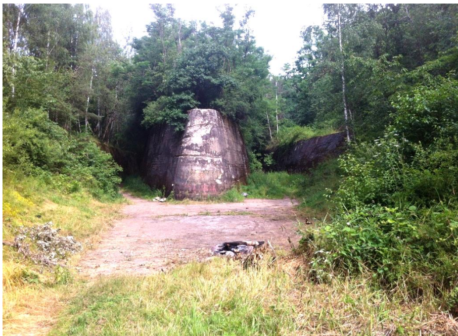
Obr. 31 – Vtokový pilíř, dělící levý a pravý tunel
