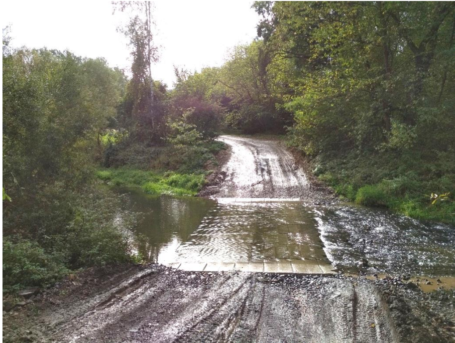
Obr. 28 – Zpevněný brod pod místem navrženého jezu
