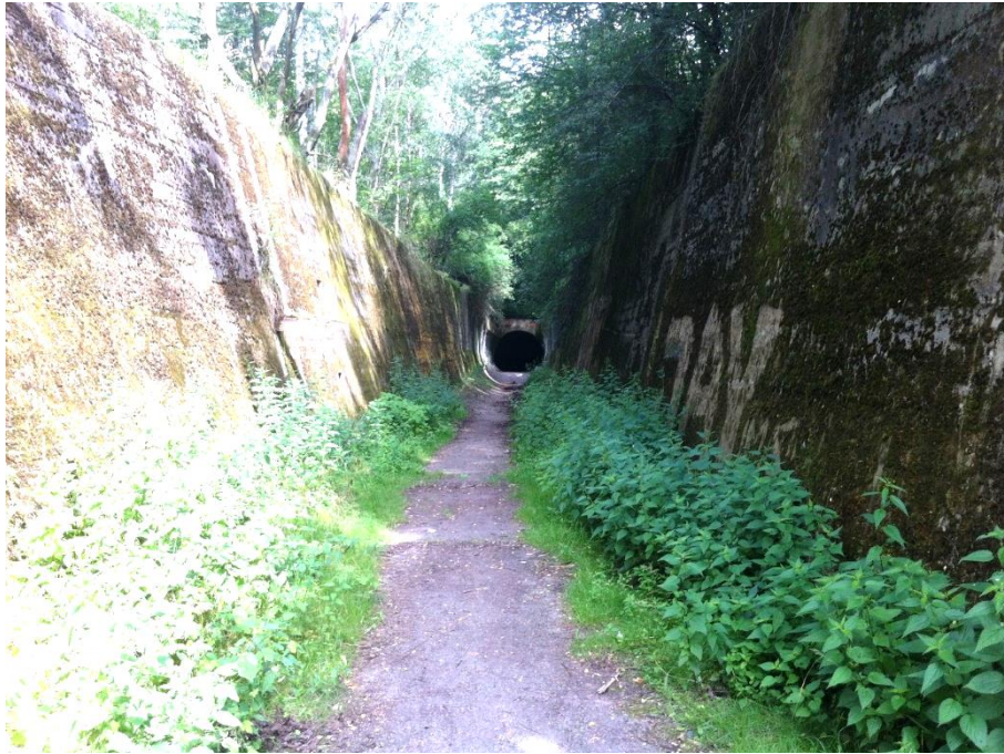
Obr. 32 – Vtok do levého tunelu
