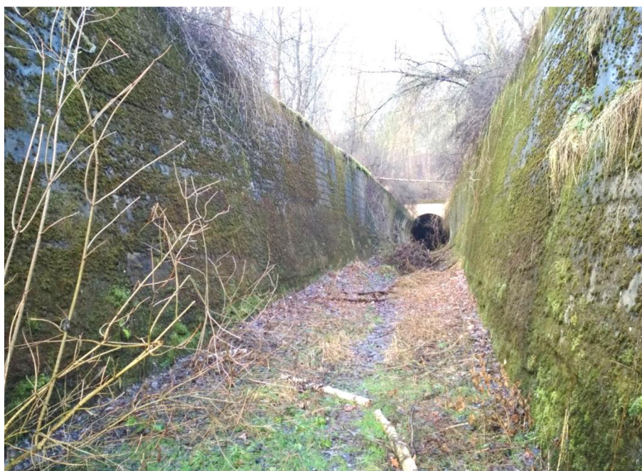
Obr. 33 – Vtok do pravého tunelu
