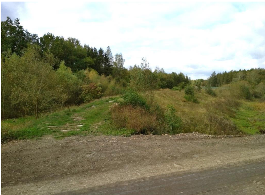
Obr. 29 – Stávající hráz a část příjezdové cesty k jezu
