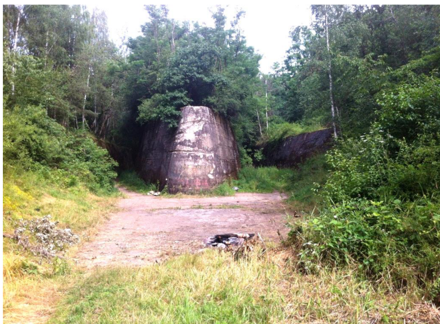
Obr. 31 – Vtokový pilíř, dělící levý a pravý tunel
