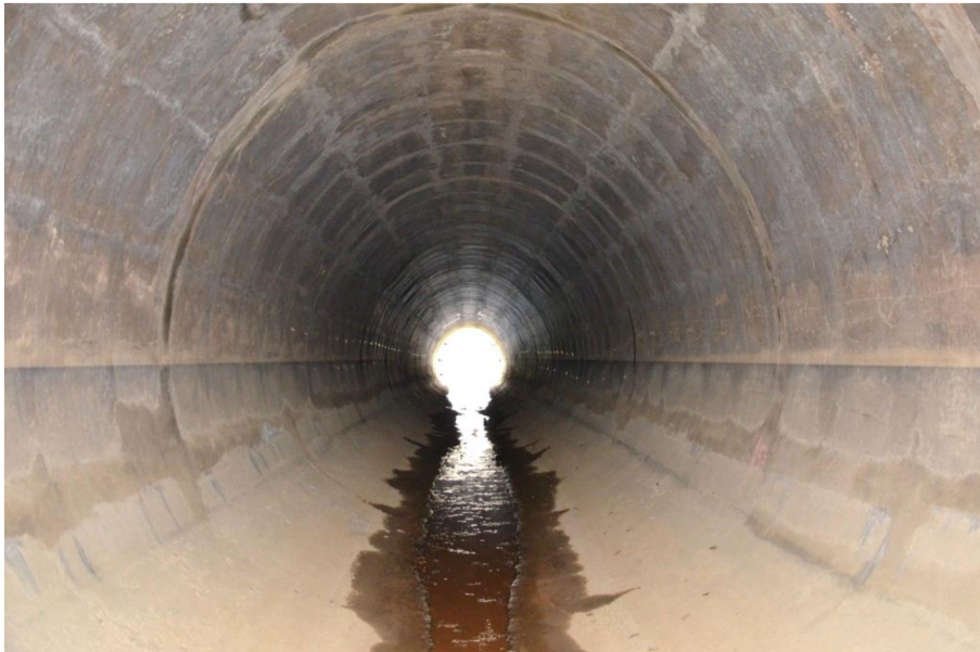
Obr. 40 – Podélné a příčné pracovní spáry v tunelu
