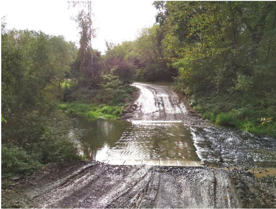
Obr. 28 – Zpevněný brod pod místem navrženého jezu
