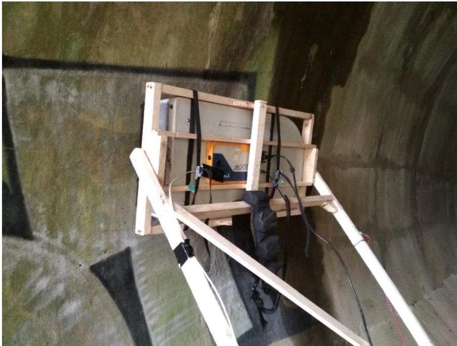
Obr. 38 – Měření metodou GPR na stěnách tunelu
