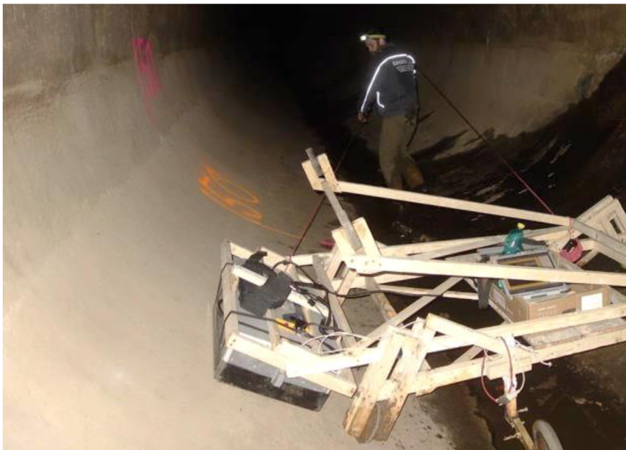
Obr. 39 – Měření metodou GPR u dna tunelu
