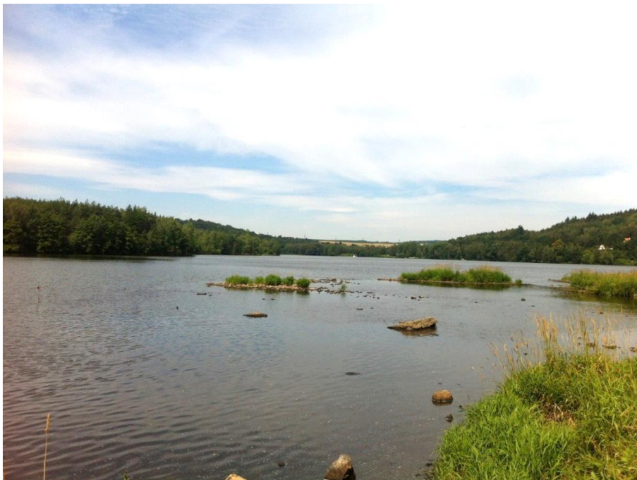
Obr. 27 – Vodní nádrž Ejpovice
